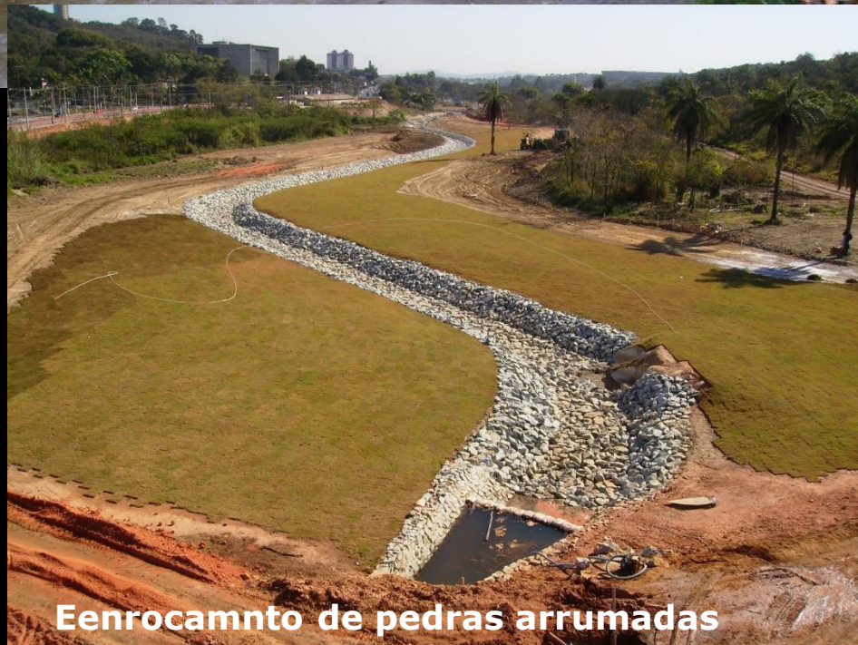
Enrocamento de pedras lançadas
