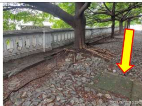
Figura 3 – Caixa de passagem na Rua “Sapucaí de baixo”, Centro/Floresta – Museu de Artes e Ofícios.
