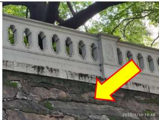
Figura 13 – Trinca no muro de arrimo, abaixo dos balaústres do guarda-corpo.
