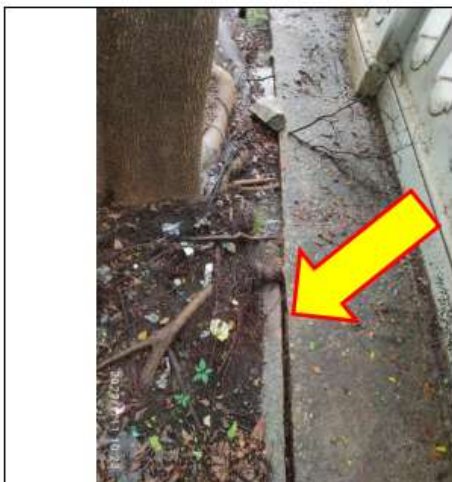
Figura 8 – Deslocamento do passeio pelo crescimento do sistema radicular da árvore.
