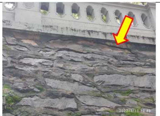
Figura 9 – Trinca no muro de arrimo, abaixo dos balaústres do guarda-corpo.
