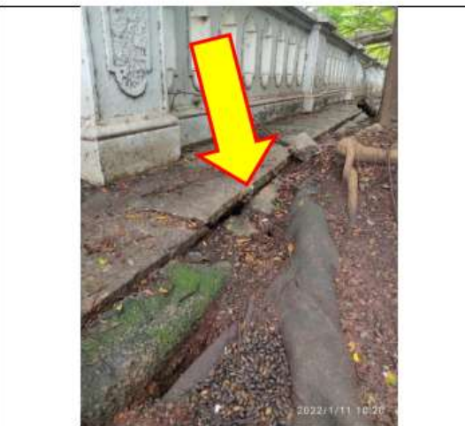
Figura 9 – Trinca no muro de arrimo, abaixo dos balaústres do guarda-corpo.
