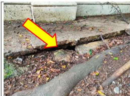
Figura 8 – Deslocamento do passeio pelo crescimento do sistema radicular da árvore.
