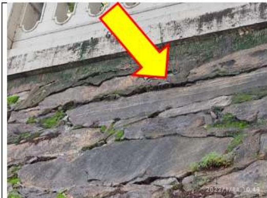
Figura 12 – Trinca no muro de arrimo, abaixo dos balaústres do guarda-corpo.
