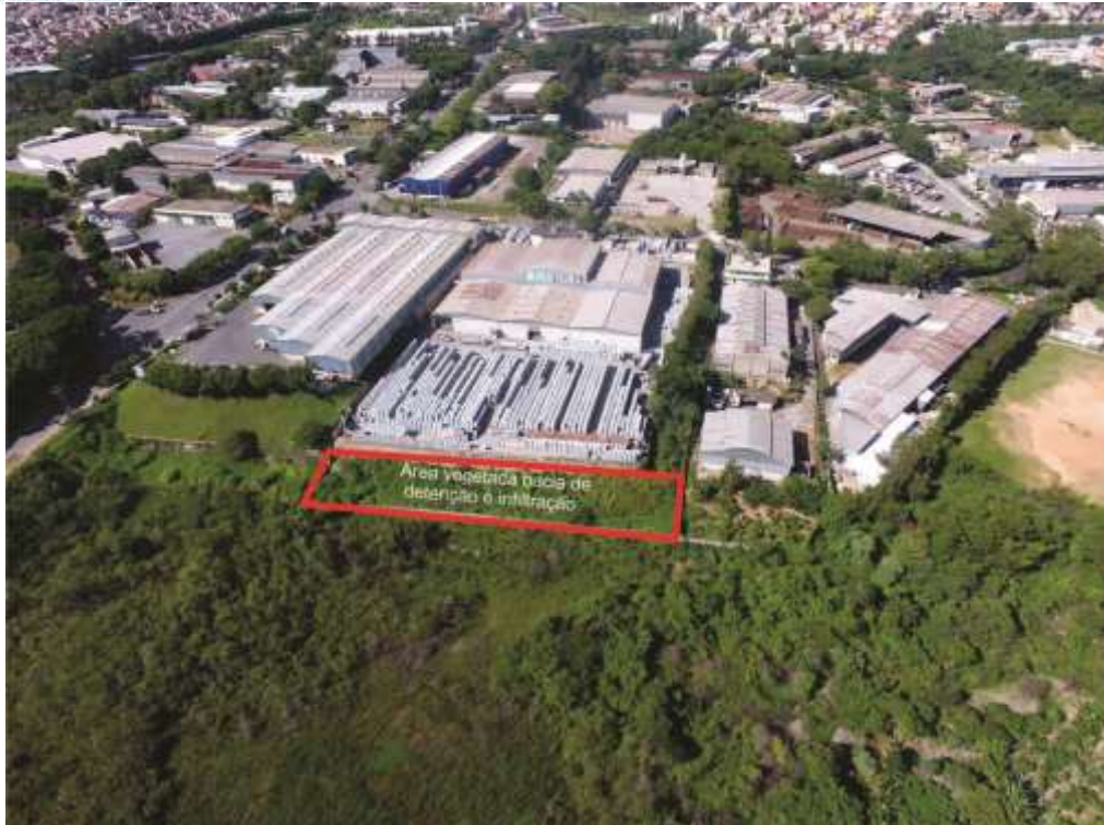
Imagem da área aos fundos do terreno vegetada e preservada para fins de bacia de detenção e infiltração.
