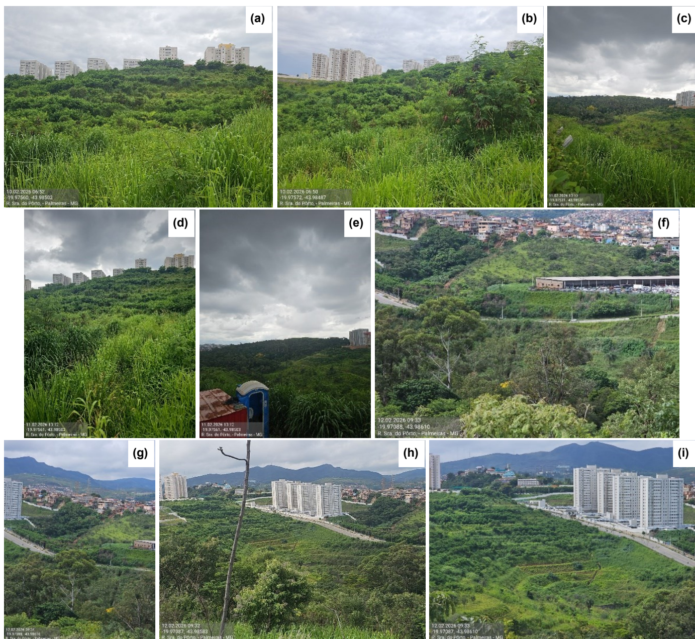
Figura 03: Em “a” a “i” situação atual de toda a área sob análise em fevereiro de 2026, com mato alto, e com características de manutenção e coroamento conforme PRAD aprovado ( Fonte: Vistoria “in loco” realizada nos dias 10, 11 e 12/02/2026).
