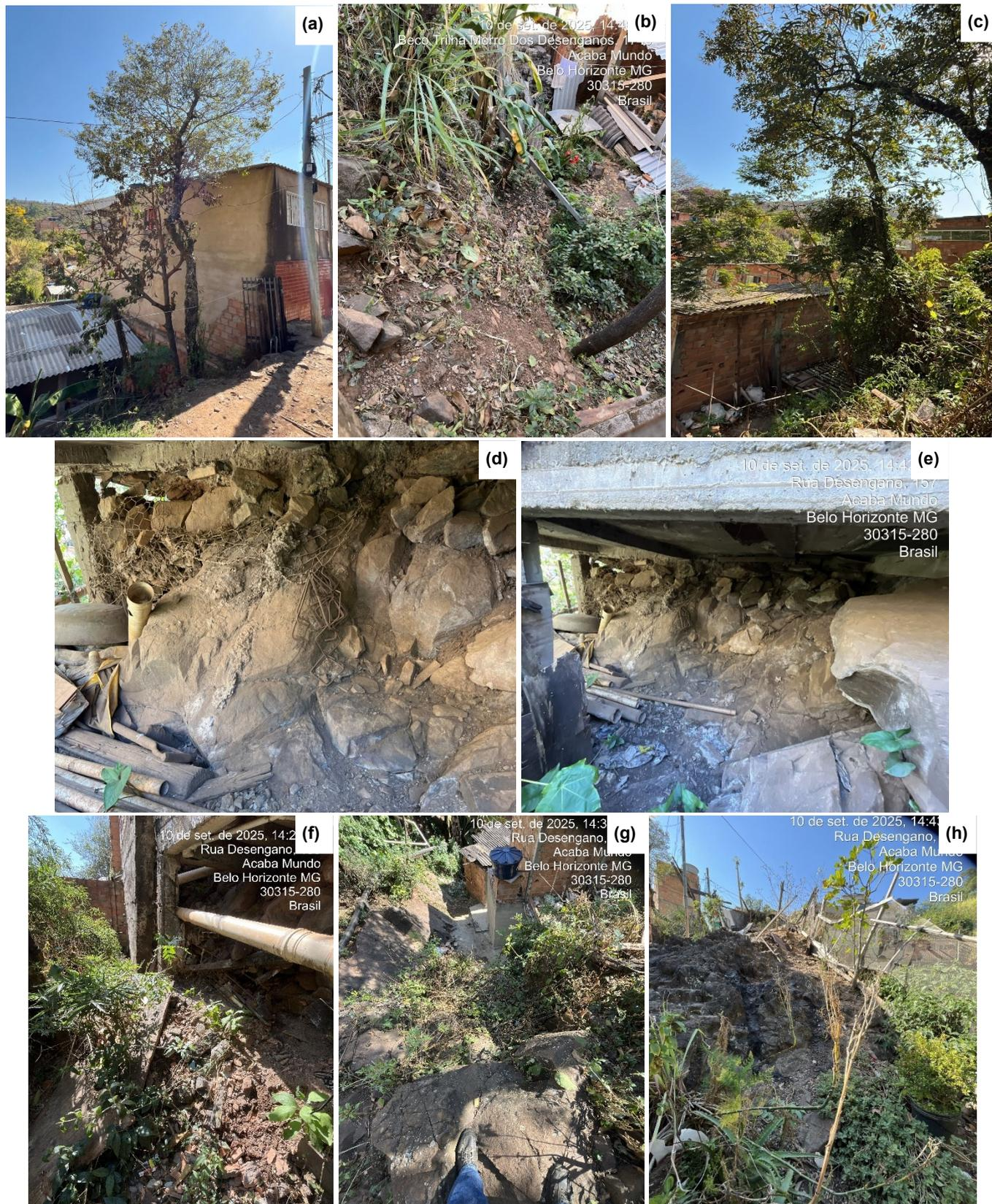
**Figura 02:** Em “a” a “h”, situação da estabilidade encosta, com edificação sobre rochas na encosta em “d” e “e” (Fonte: Vistoria in loco realizada em 10/09/2025).
