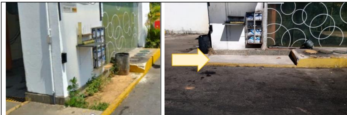
Figura 7 – Área permeável próxima ao lavajato e sua impermeabilização, conforme solicitado pela SMMA.
