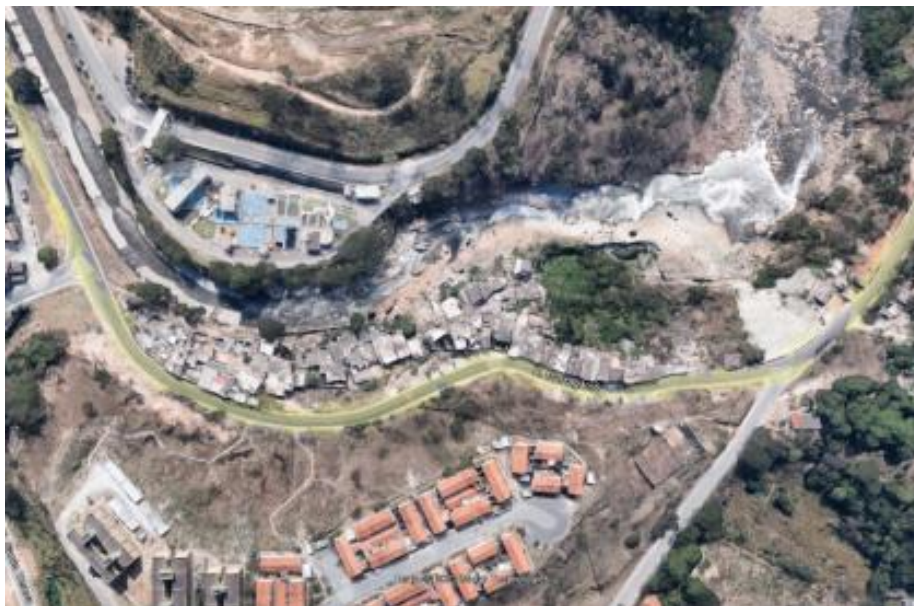
Figura 1 – Vila da Área, antes da intervenção. Fonte: Estudos Ambientais, SMMA, 2025.
