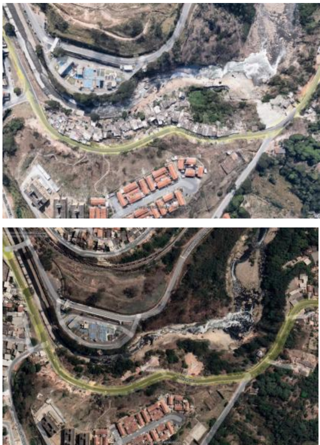
Figura 2 – Situação anterior e situação atual da Vila. Fonte: SMMA, 2025.
