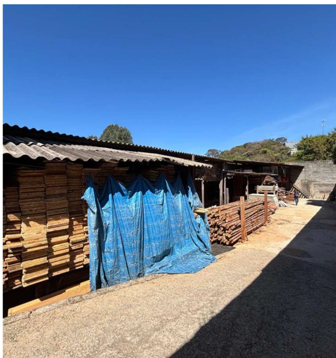
Figura 4. Vista do empreendimento. Disponível no ticket 31.00743999/2025-91, no arquivo Relatório Fotográfico.
