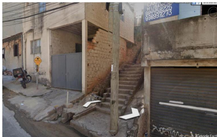
Figura 1 - Entrada para a Rua Ouro Fino a partir da Rua Joaquim Teixeira dos Anjos
