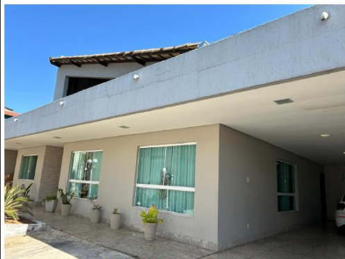
4 – Fachada frontal da edificação – 01/08/2025
