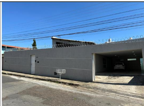
3 – Grail da edificação – 01/08/2025
