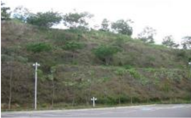
Foto 7 – Detalhes dos taludes, canaletas de drenagem e cobertura vegetal com forrações e plantio de mudas nas cristas.
