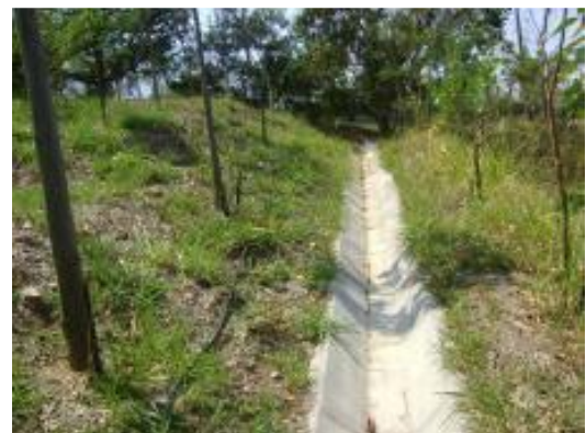
Foto 12 – Sistemas de drenagem instalados na área (canaletas).
