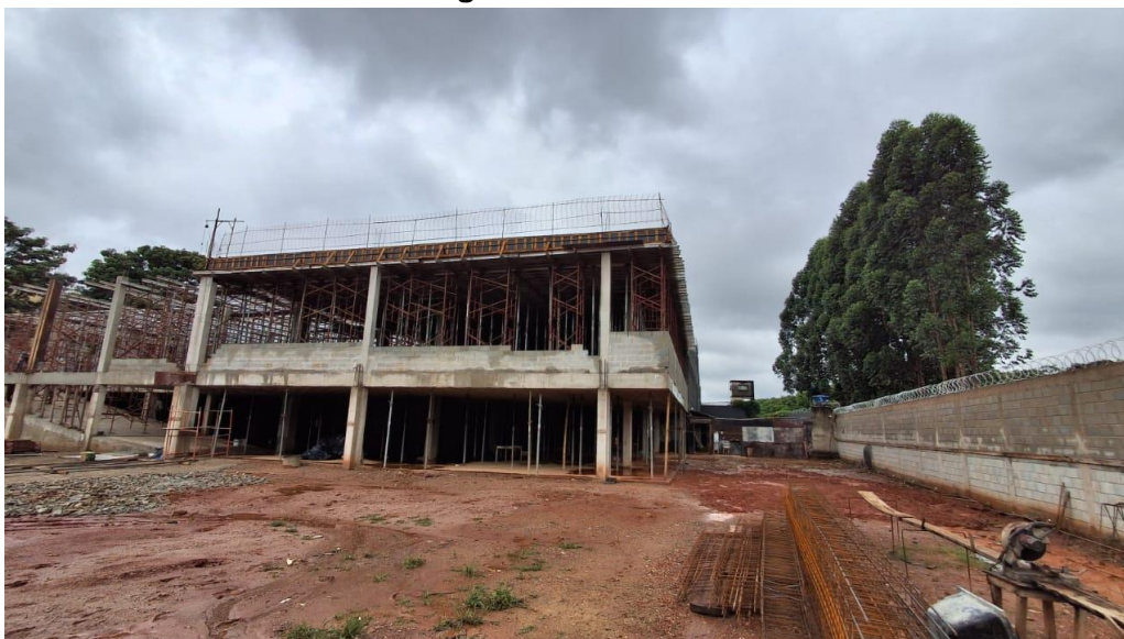
Foto 1 – Vista geral da obra em andamento.
