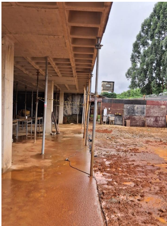
Foto 3 – Piso concretado na faixa que deveria estar impermeabilizada.
