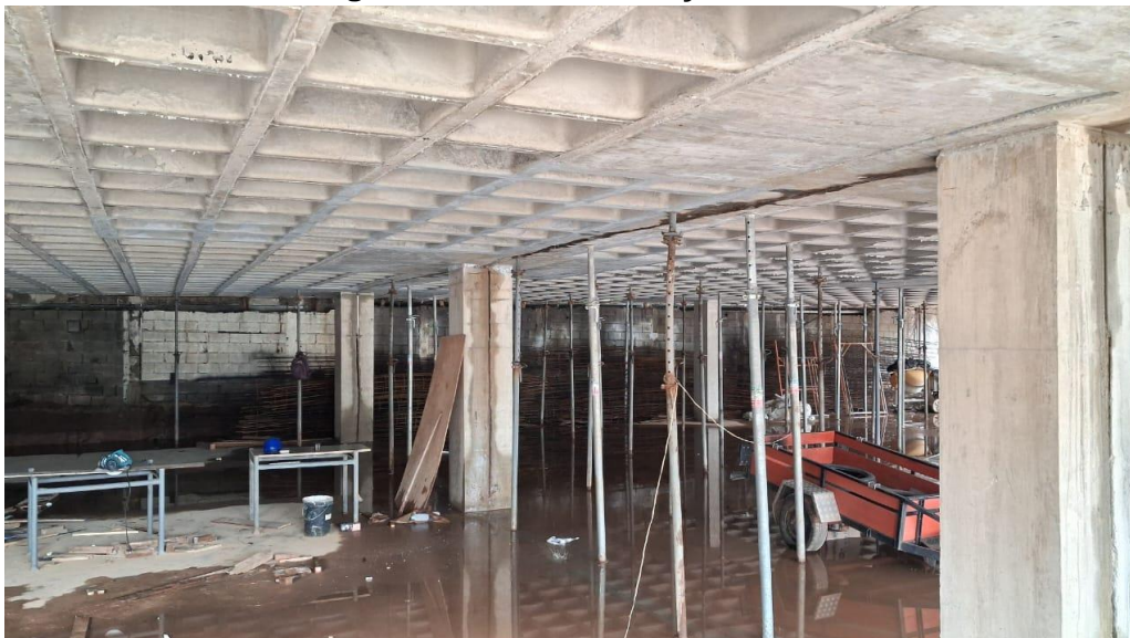
Foto 2 – Vista geral interna à edificação sendo construída.
