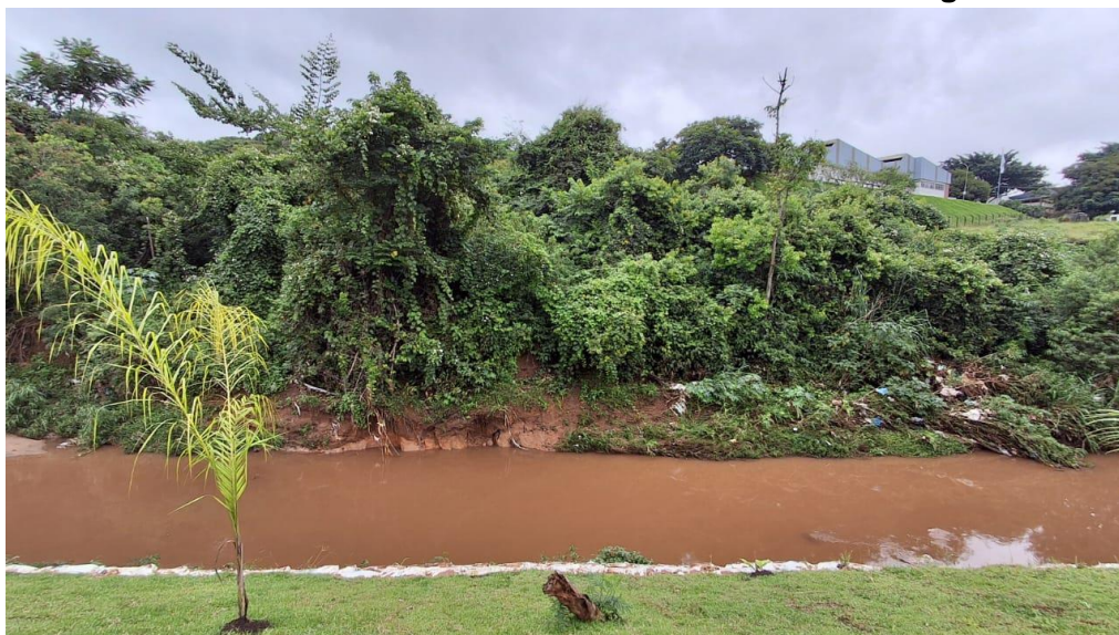
Foto 4 – vista do talude retificado na beira do córrego.
