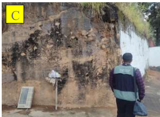
Figura 26 – Registros fotográficos de inspeção: (A) Resíduos de demolição; (B) Trinca no muro de arrimo da Rua Carlos Pinheiro Chagas; (C) Erosão no arrimo da Rua Carlos Pinheiro Chagas; (D) Ondulações no muro de divisa.
