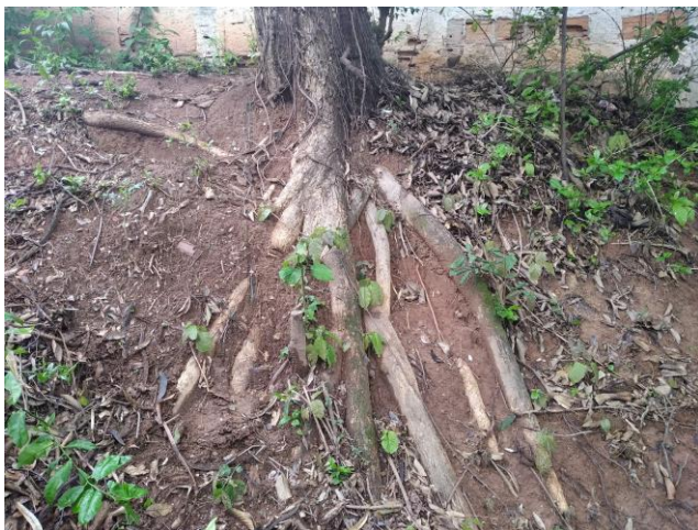
Figura 1 – raízes de sustentação expostas
