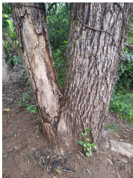
Figura 3 - lesão no galho da bifurcação primária
