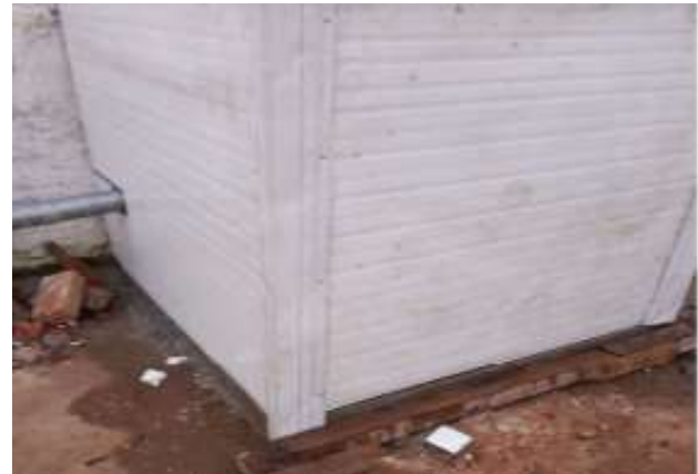
Figura 2: Fotografia da proteção acústica instalada pela empresa na bomba hidráulica (fonte: Hipercarnes, ticket BHdigital31.00573232/2022-11)
