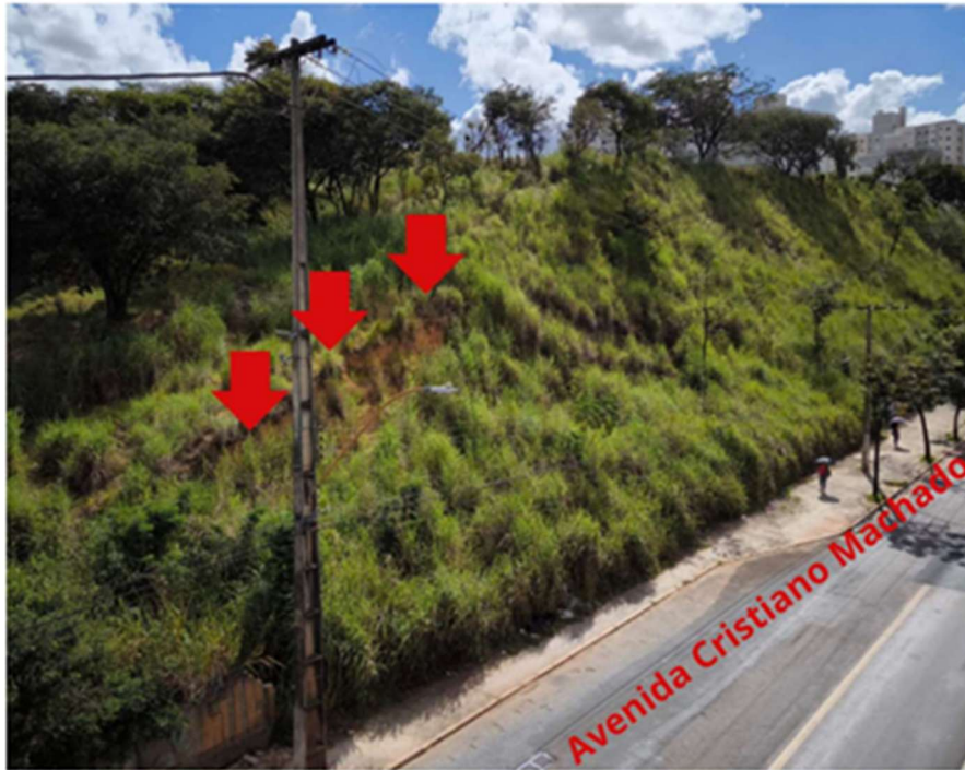
Figura 11: Cicatriz de deslizamento observado no talude da Av. Cristiano Machado. Fonte: Memorial Descritivo_Projeto Terraplenagem_Condomínio Residencial – Área Sarana
