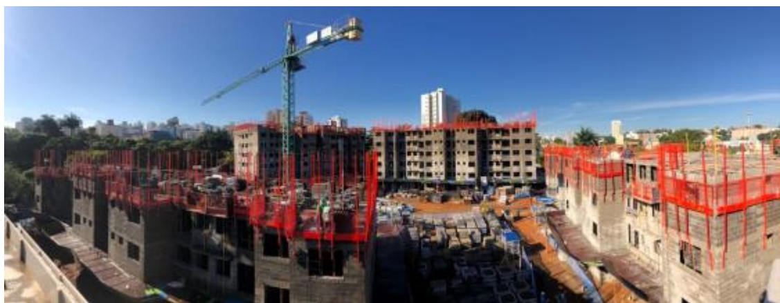
Fig. 2 – Estágio atual da execução do empreendimento. Fonte: Protocolo SMMA nº 00473/20
