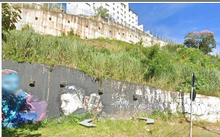
Fig. 3 – Intervenção realizada: Encosta do Bicão. Fonte: Urbel, 2026
