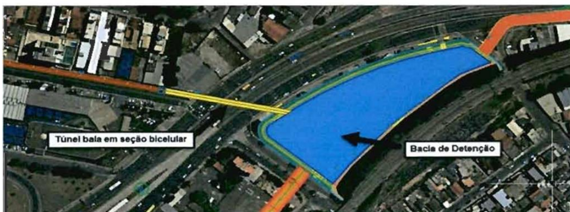
Praça das Águas 2 – Córrego Cachoeirinha
