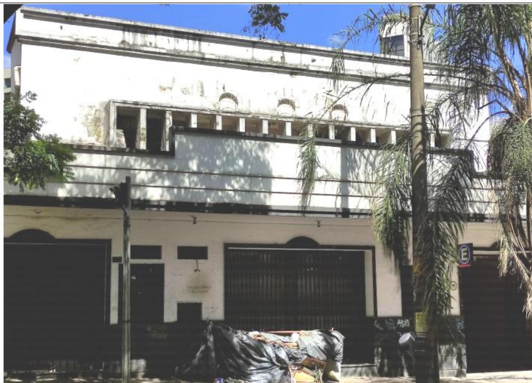
Vista atual da edificação. Fonte: Documentação encaminhada no protocolo online 0211/2021
