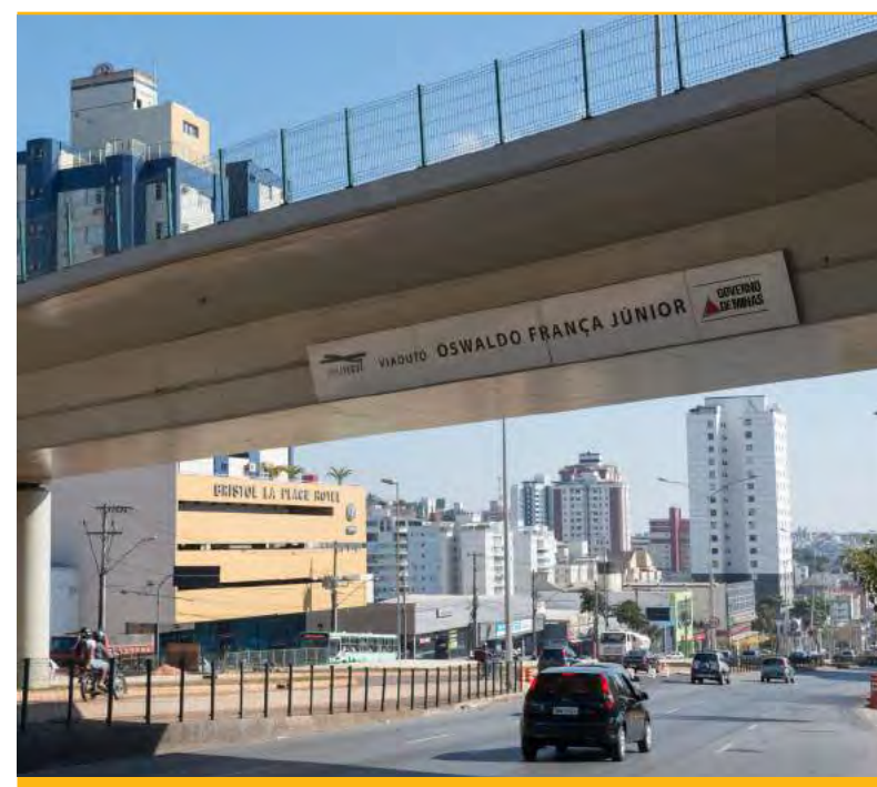
Viaduto Oswaldo França Júnior – Avenida Cristiano Machado Foto: Pedro Nicoli, 2013
