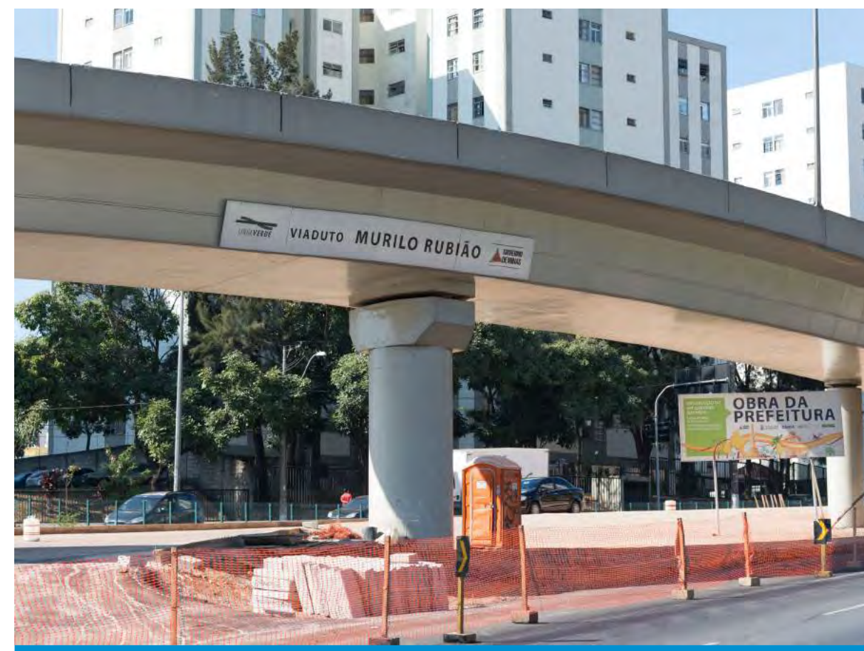
Obras na Avenida Cristiano Machado, 2013 — Foto: Pedro Nicoli
