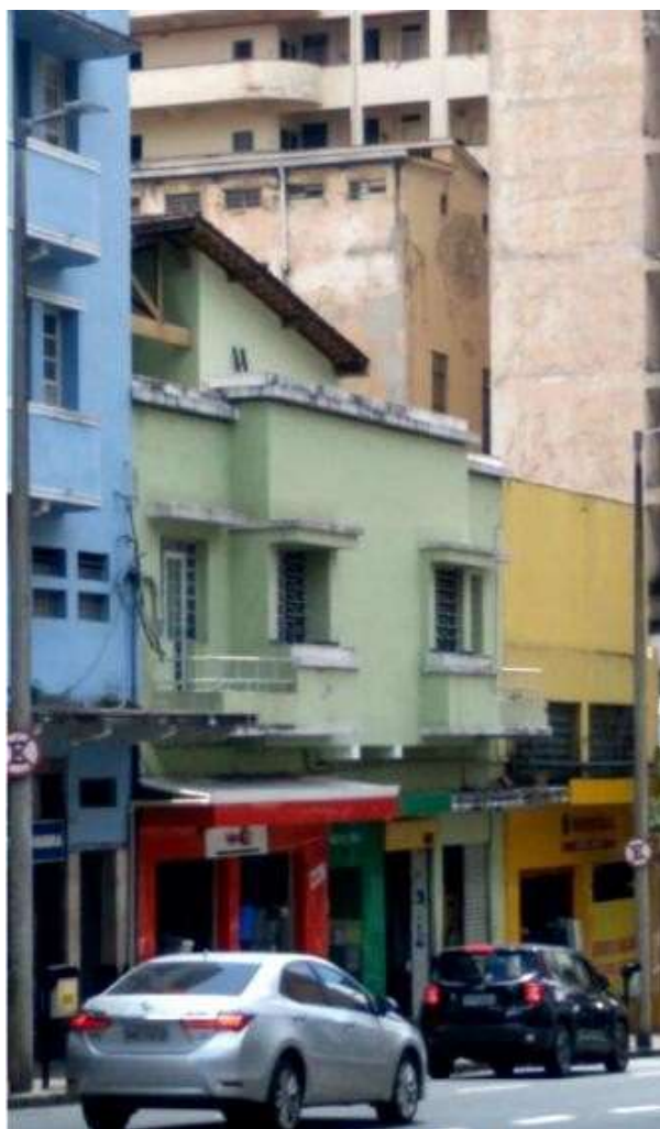
Vistas do imóvel, com destaque para o acréscimo construído irregularmente no topo da edificação. Fonte: protocolo 135/2022
