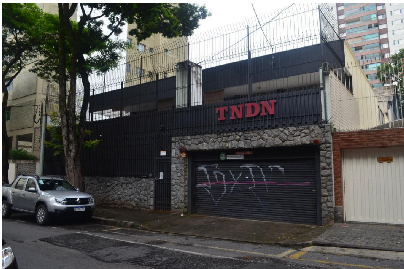
Figura 51: Vista de trecho da fachada lateral esquerda cega na divisa dos imóveis. Vista para a platibanda e o telhado embutido no reforço estético da tipologia modernista da edificação. Fonte: Eliana Ronki, material apresentado para celeridade, 2022.
