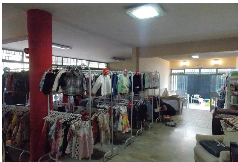
Figura 62: Vista do antigo almoço. No projeto aprovado havia uma parede que separava o almoço da sala de estar e do vestibulo da edificação. Observa-se que o cômodo foi ampliado em relação ao projeto aprovado, passando a porta para a área externa a se alinhar a parede externa da sala de jantar. Anteriormente, almoço compreendia a área que possui piso em mármore, a parte em que se vê o porcelanato era uma espécie de pátio. Fonte DPCA, 2022.
