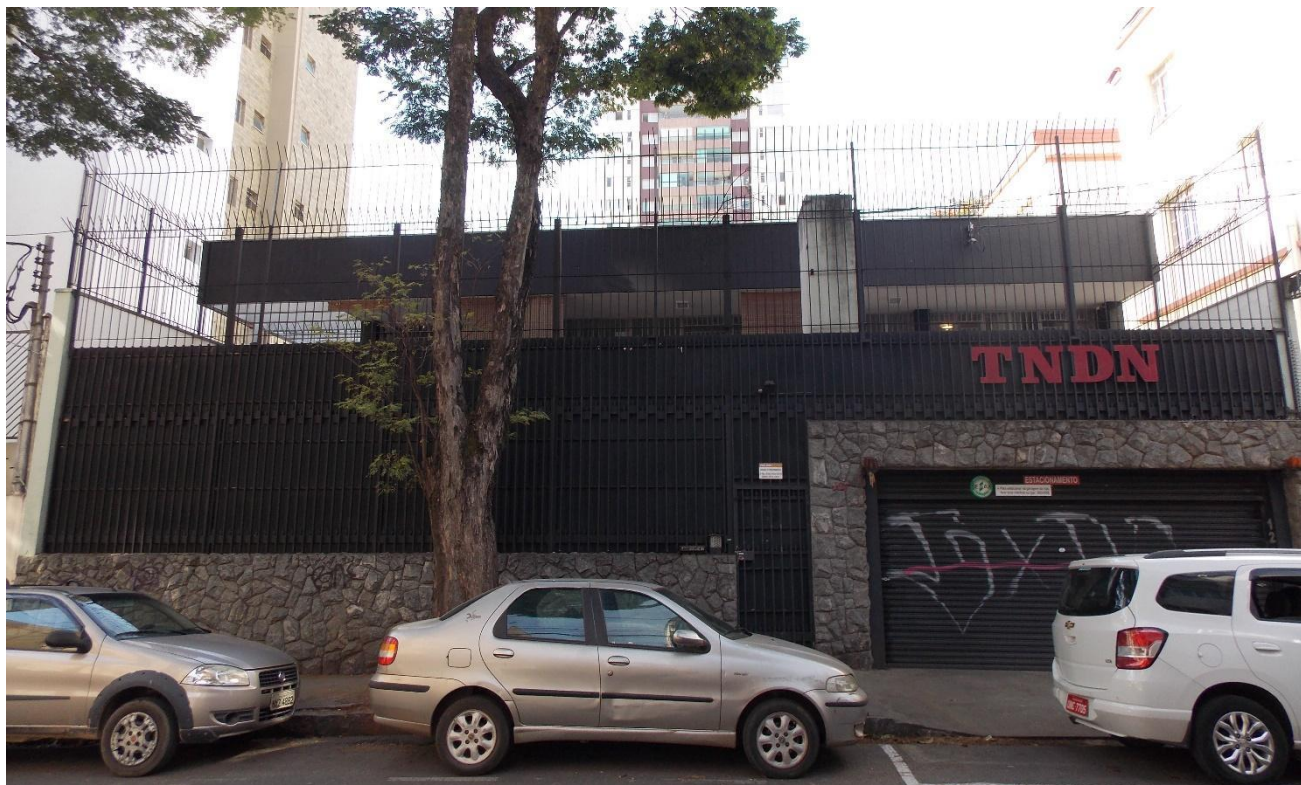
Figura 50: Vista da fachada frontal do bem cultural com engenho de publicidade no gradil acima do acesso garagem e vista parcial do beiral da fachada frontal atrás da parte vazada do gradil elevado. Fonte: DPCA, 2022.
