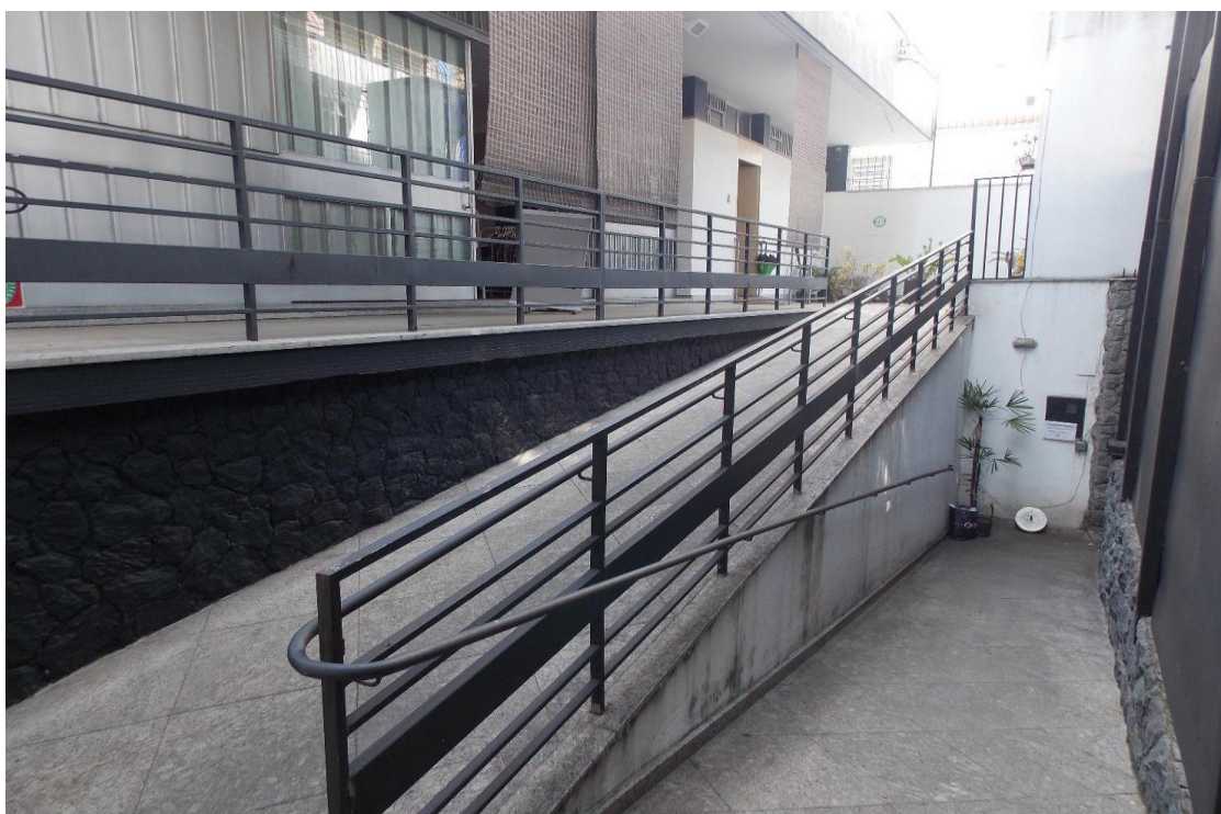
Figura 56: Vista da rampa e da fachada da edificação. Fonte DPCA, 2022.
