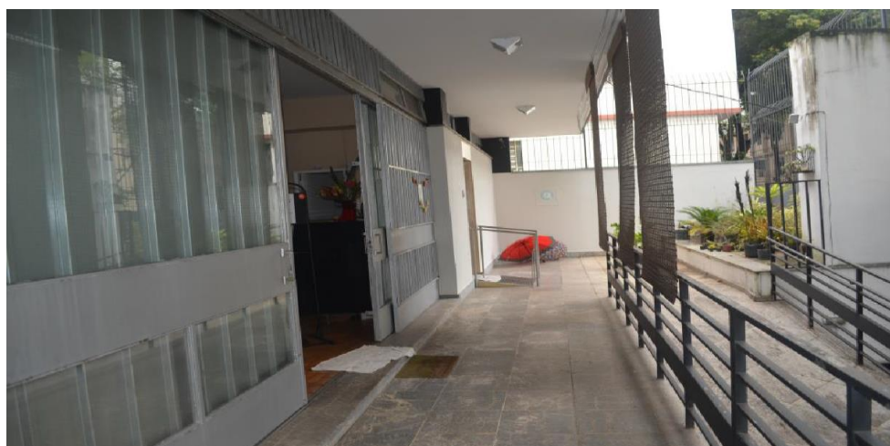
Figura 54: Vista da varanda com piso de mármore e fachada frontal. Fonte: Eliana Ronki, material apresentado para celeridade, 2022.
