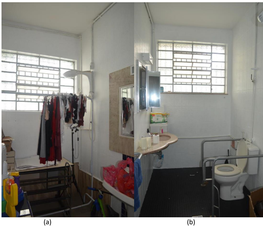
Figura 71 a-b: Vista dos dois banheiros, um voltado para a fachada lateral direita e outro voltado para a fachada lateral esquerda. Fonte: Eliana Ronki, material apresentado para celeridade, 2022.
