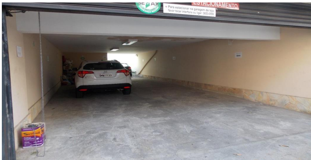
Figura 57: Vista interna da garagem. Fonte: DPCA, 2022.
