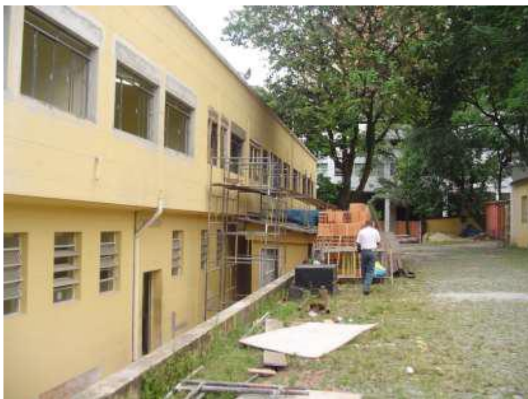
Estacionamento posterior da ESP, com as alterações das esquadrias (substituições de janelas). Obra de 2007-2008.
