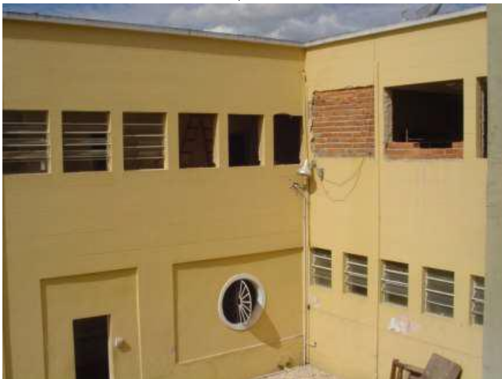
Estacionamento interno da ESP, com as alterações das esquadrias (fechamento de vãos e substituições de janelas). Obra de 2007-2008.
