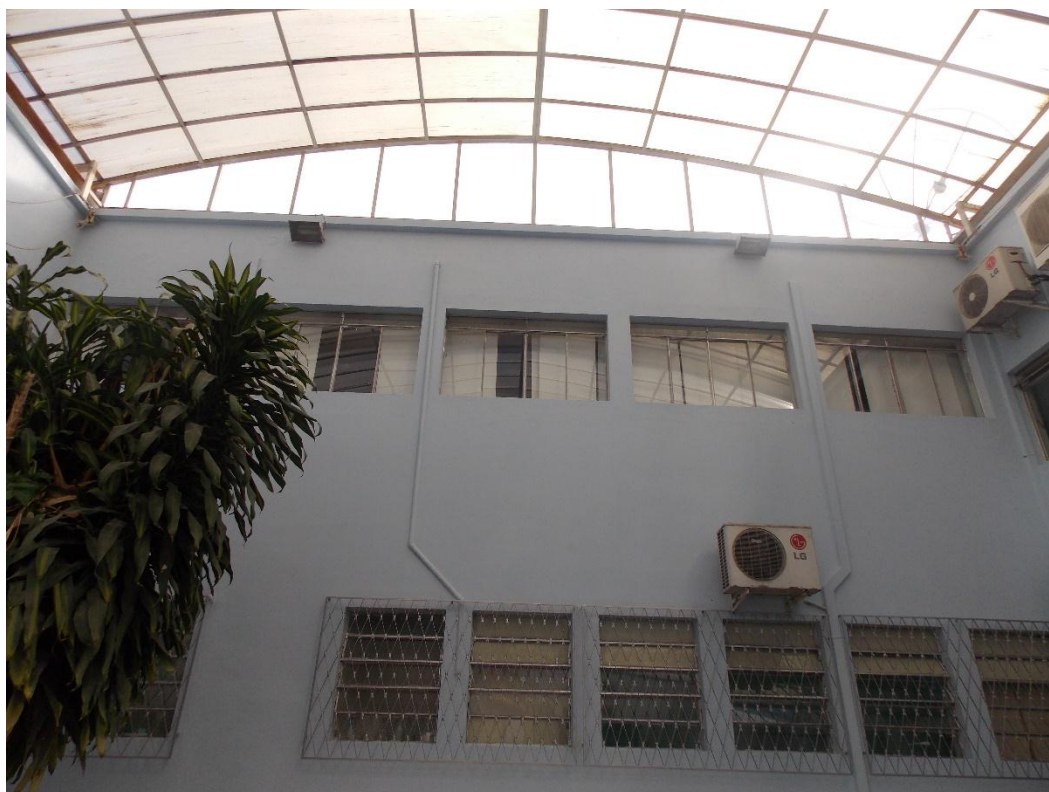
Cobertura do pátio interno: Fonte: DPCA - Junho 2022.
