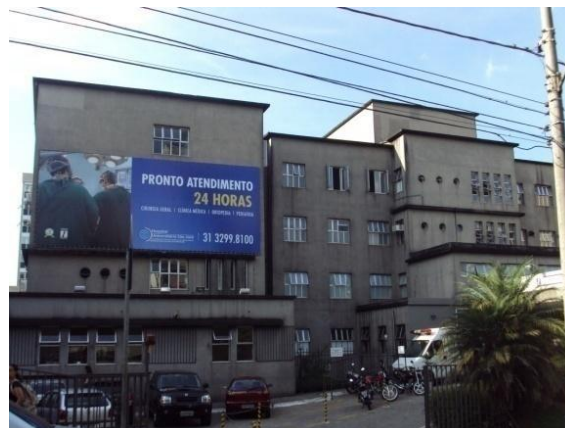
Vista geral do prédio do hospital HUSJ. Data: out./2009. Fonte: DPCA /FMC
