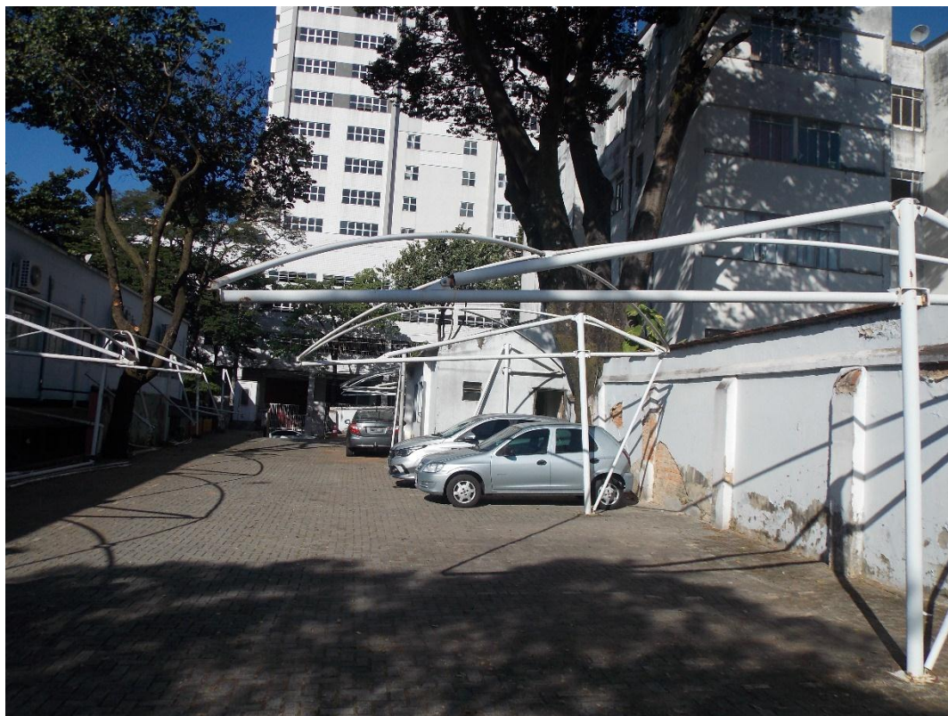
Estrutura das coberturas em lona do estacionamento: Fonte: DPCA - Junho 2022.
