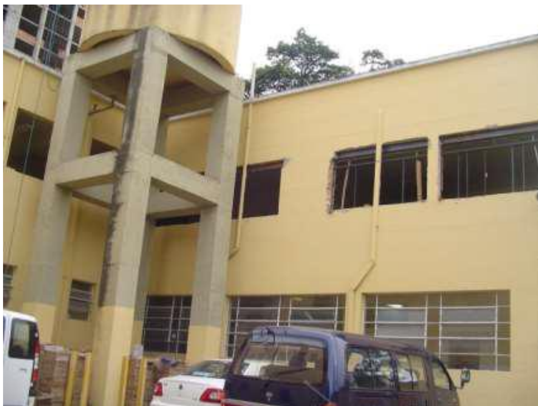
Estacionamento interno da ESP, com as alterações das esquadrias (substituições de janelas). Obra de 2007-2008.
