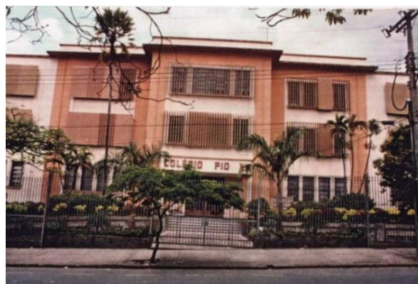
Vista da fachada frontal do Colégio Pio XII, onde a pintura destaca a entrada principal. Data: 1992. Fonte: RD/DIPC/FMC
