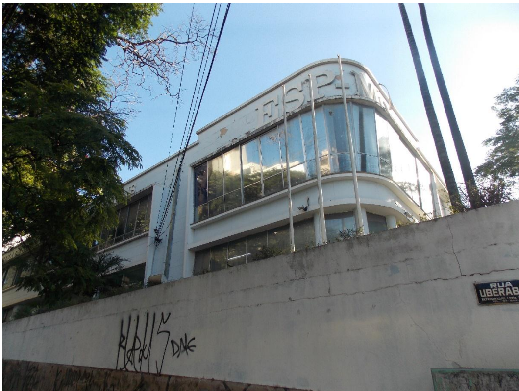
Detalhe da fachada: Fonte: DPCA - Junho 2022.
