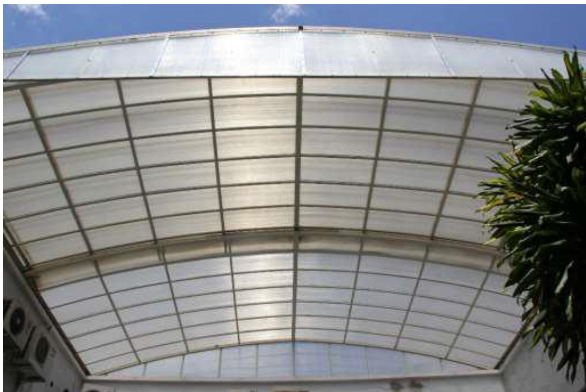
Cobertura abobadada de policarbonato alveolar do pátio interno da ESP. Fonte: Sérgio Fagundes, 2018.
