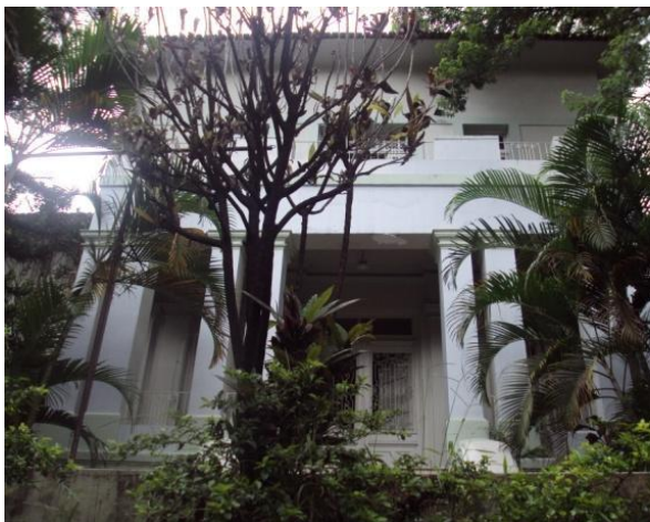
Vista da fachada frontal da Escola Estadual Professor Caetano Azeredo. Data: out./2009. Fonte: DPCA/FMC
