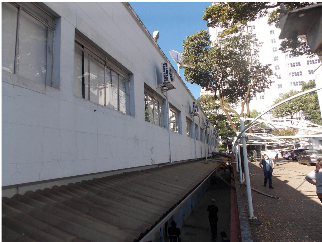
Fachada lateral – parte superior: Fonte: DPCA - Junho 2022.
