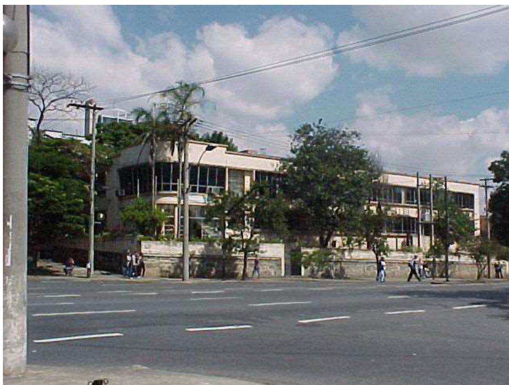
Detalhe corpo central e fachada da Avenida Augusto de Lima. Fonte: acervo bibliográfico da ESP.
