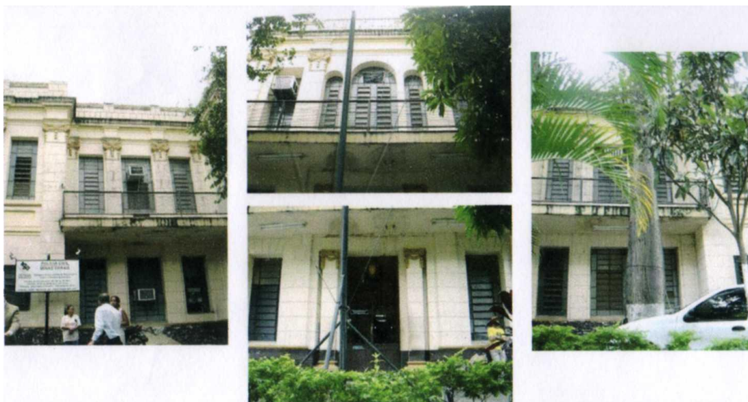
Sede da Antiga Delegacia Especializada em Repressão a Furtos e Roubos de Veículos Demonstração dos elementos que compõem a regularidade de cheios e vazios da fachada frontal, com destaque para a sacada central projetada para frente. Data: Dez./2005. Fonte: RD/DPCA/FMC.
