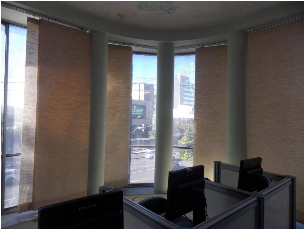
Detalhe das colunas estruturais independentes da janela em fita : Fonte: DPCA - Junho 2022.
