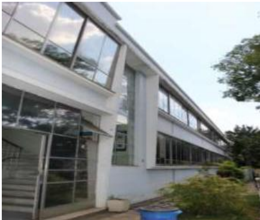
Detalhe da entrada da ESP. Fonte: Sérgio Fagundes, 2018.
