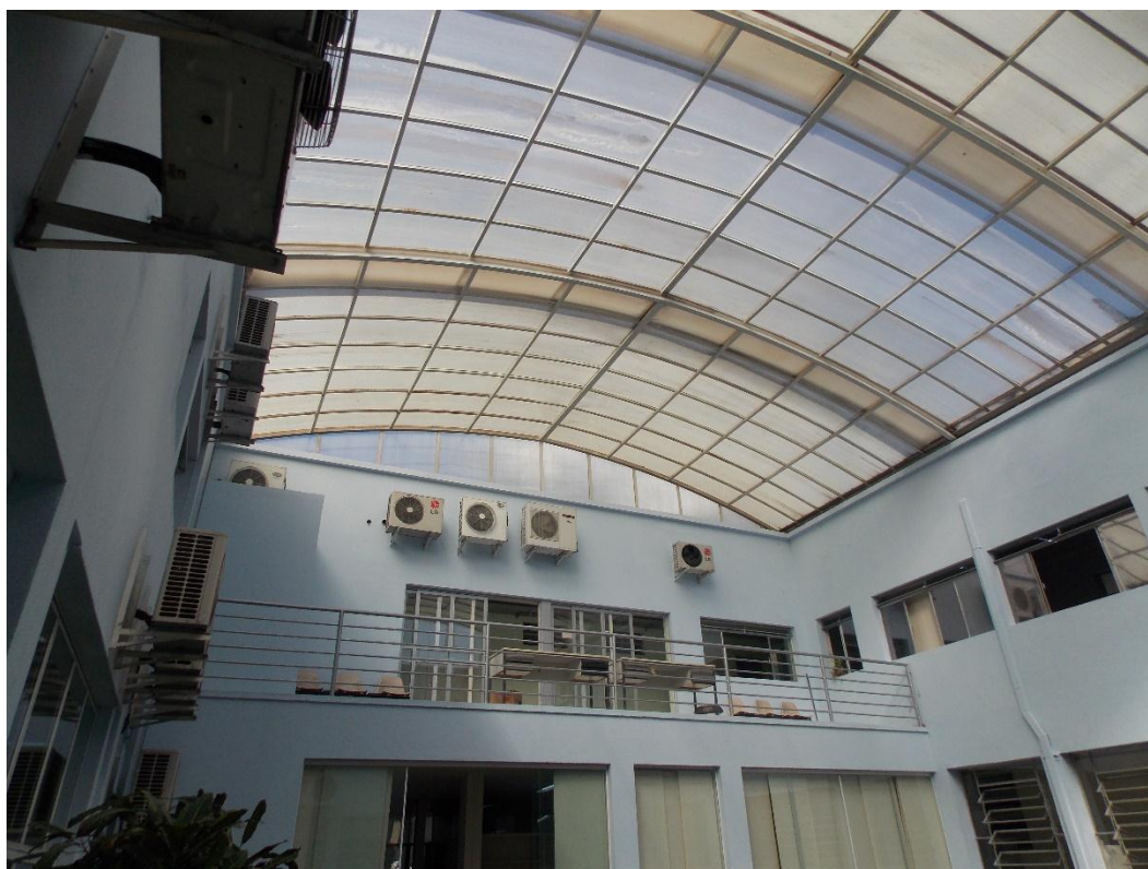
Cobertura pátio interno: Fonte: DPCA - Junho 2022.
