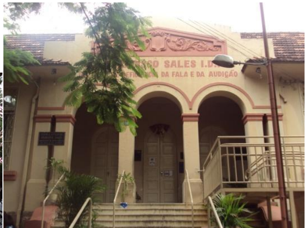
Vista da fachada frontal da Escola Estadual Francisco Sales Data: out./2009. Fonte: DPCA /FMC
