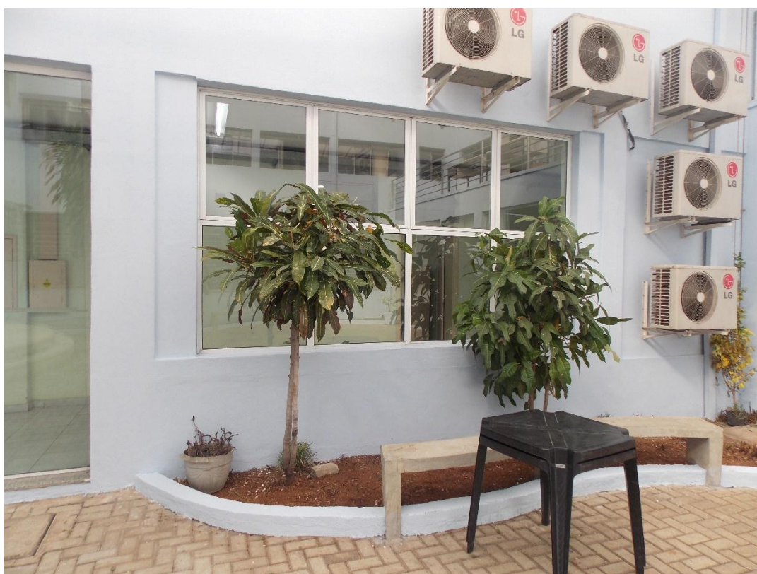
Detalhe do pátio interno: Fonte: DPCA - Junho 2022.
