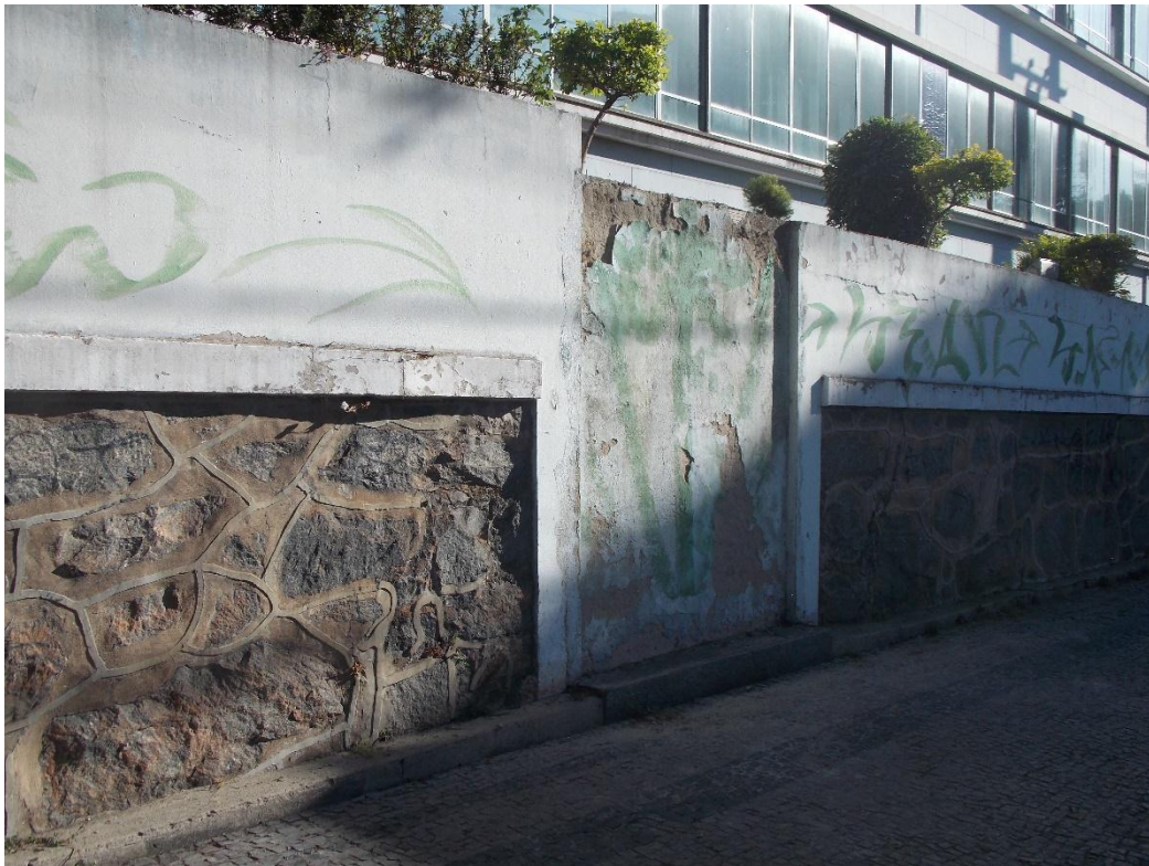
Detalhe muro com embasamento em pedra: Fonte: DPCA - Junho 2022
