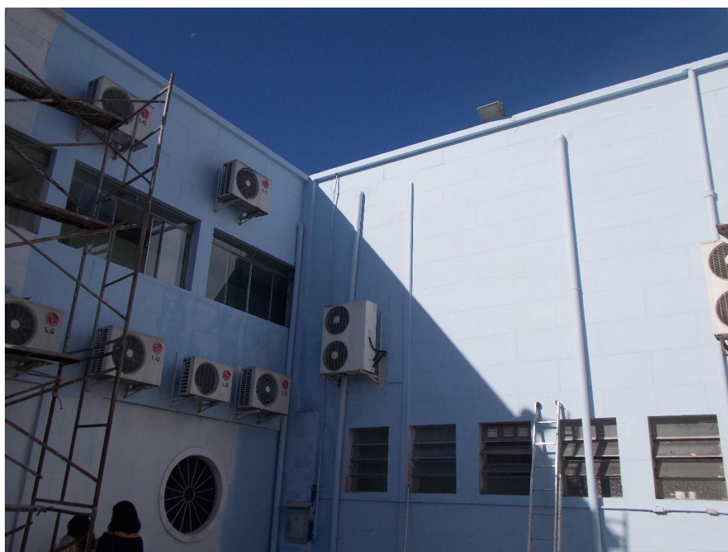
Fachada interna na reentrância da volumetria, recebendo nova pintura: Fonte: DPCA - Junho 2022.
