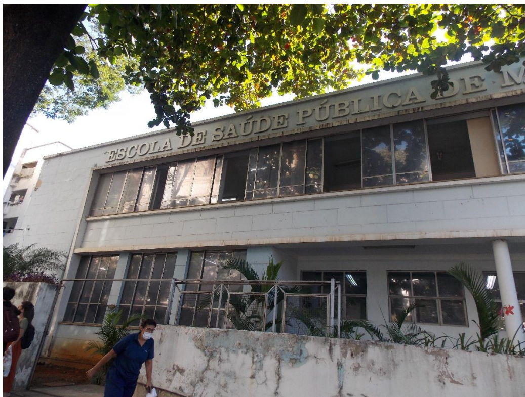
Detalhe fachada e gradil: Fonte: DPCA - Junho 2022.
