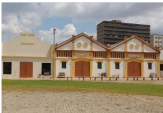
Vista externa dos galpões 03, 04 e 05. Fonte: Memorial Descritivo
