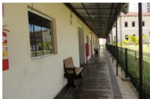
Vista parcial do anexo administrativo. Fonte: Memorial Descritivo
