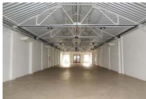
Vista interna do galpão 05. Fonte: Memorial Descritivo
