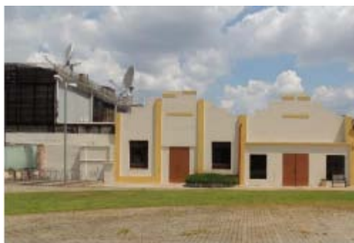
Vista externa dos galpões 05 e 06. Fonte: Memorial Descritivo
