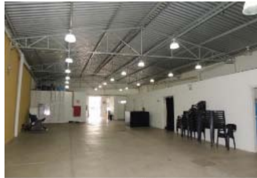
Vista interna do galpão 02. Fonte: Memorial Descritivo
