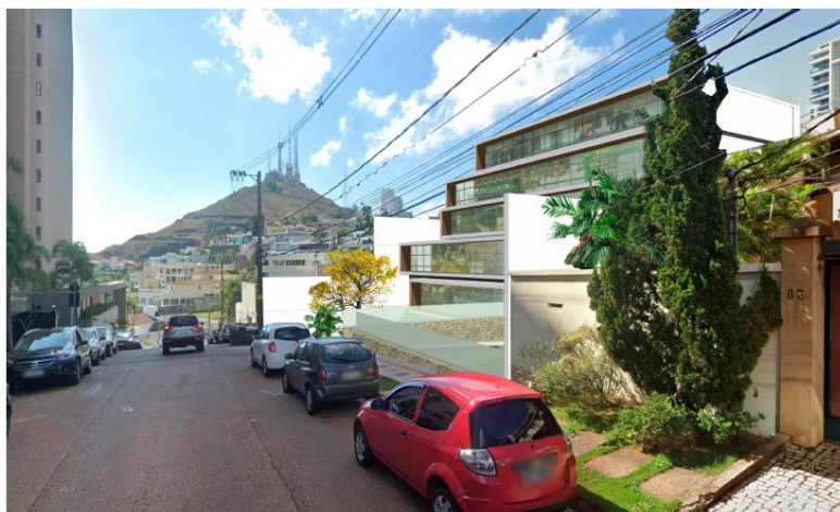
Foto inserções da edificação a partir da Rua Fausto Nunes Vieira em direção à Serra do Curral – morro das antenas. Fonte: material fornecido pelo requerente.
