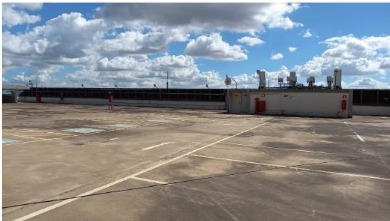
Imagem da cobertura da edificação, onde se pretende instalar o Boeing
