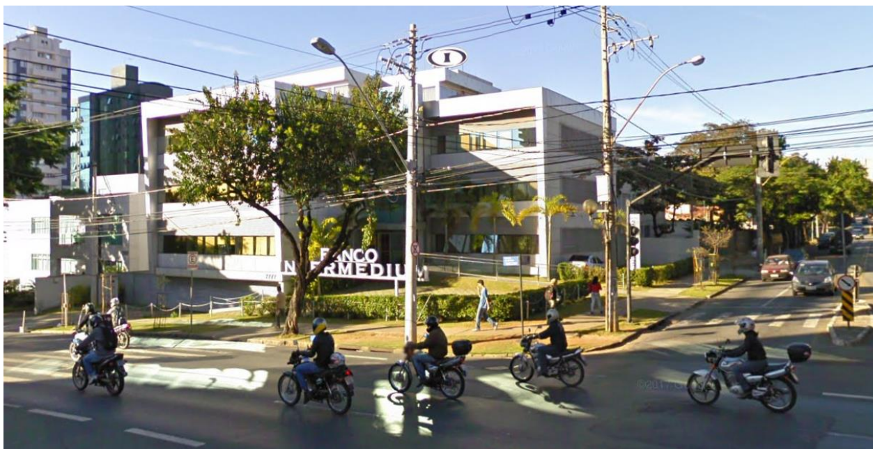
Figura 5: Foto de julho de 2009, na esquina da Avenida do Contorno e Rua Conde Linhares, a porção à esquerda da circulação vertical já estava construída. Fonte: Google Maps.
