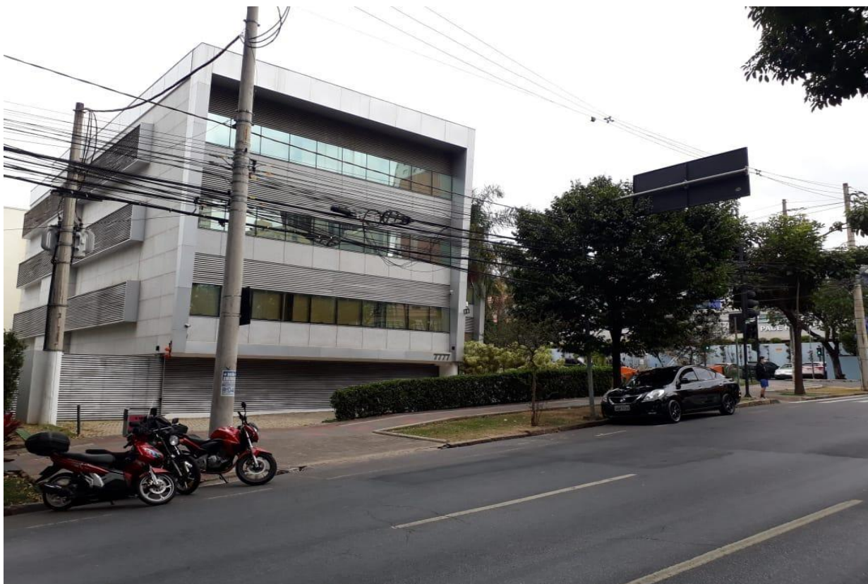
Figura 9: Foto de junho de 2021, fachada da edificação, capturada no canteiro central da Avenida do Contorno. Fonte: imagem fornecida pelo requerente em relatório fotográfico.
