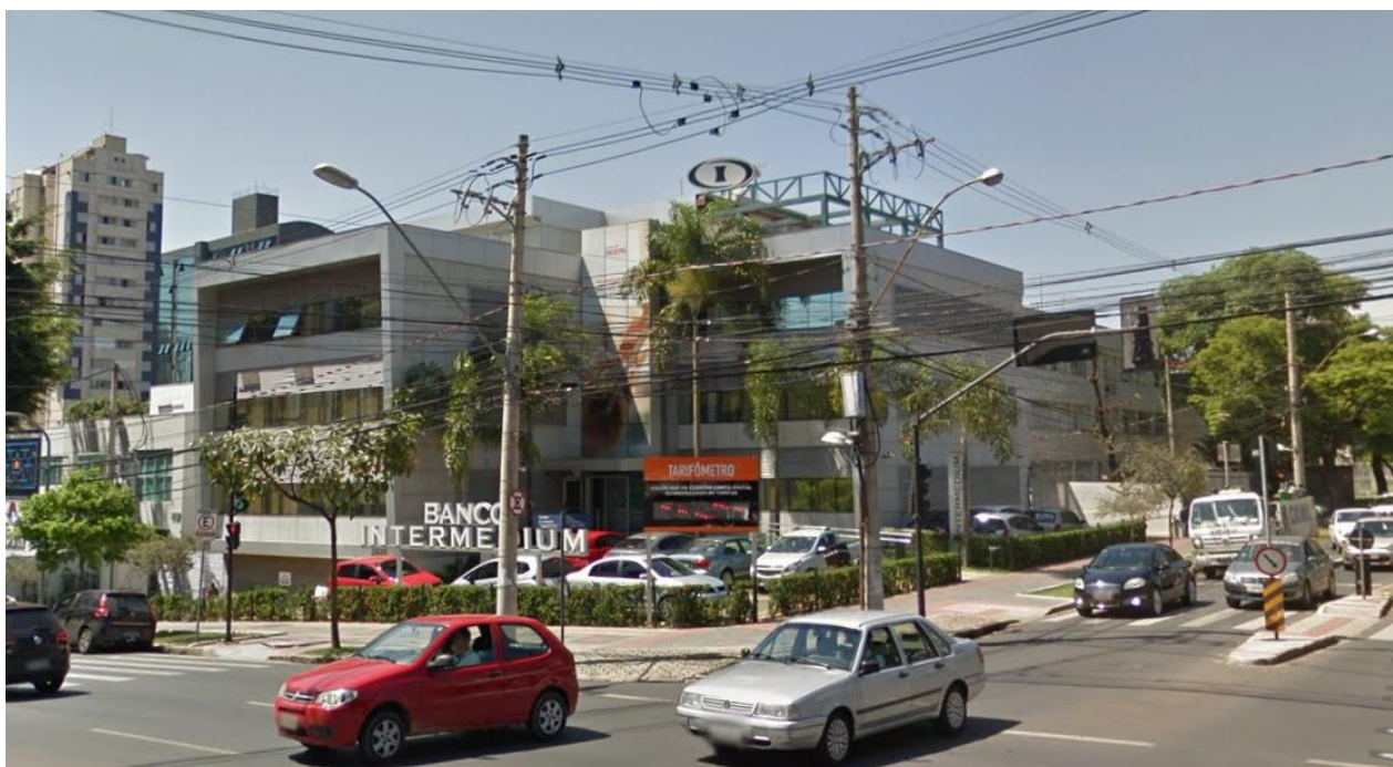
Figura 6: Foto de outubro de 2016, na esquina da Avenida do Contorno e Rua Conde Linhares, a porção à direita da circulação vertical estava em construção. Fonte: Google Maps.
