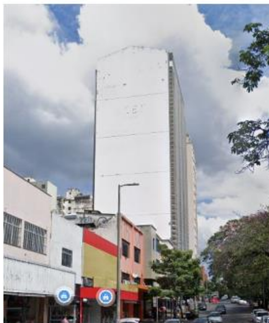
Vista da empena do edifício nº 956 a partir da com Av. Olegário Maciel
