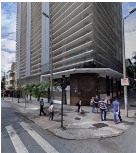
Edificação de número 956, vista a partir da esquina Av. Olegário Maciel
