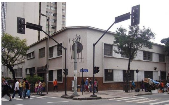
Edificação de número 908, vista a partir da esquina da Rua dos Tupinambás com Guarani
