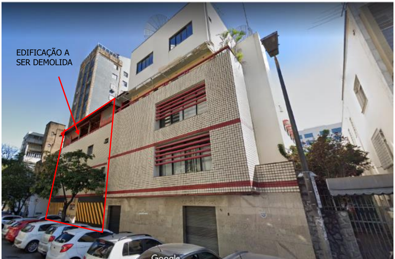
Destaque da edificação a ser demolida para instalação do edifício e a edificação vizinha existente. Fonte:
