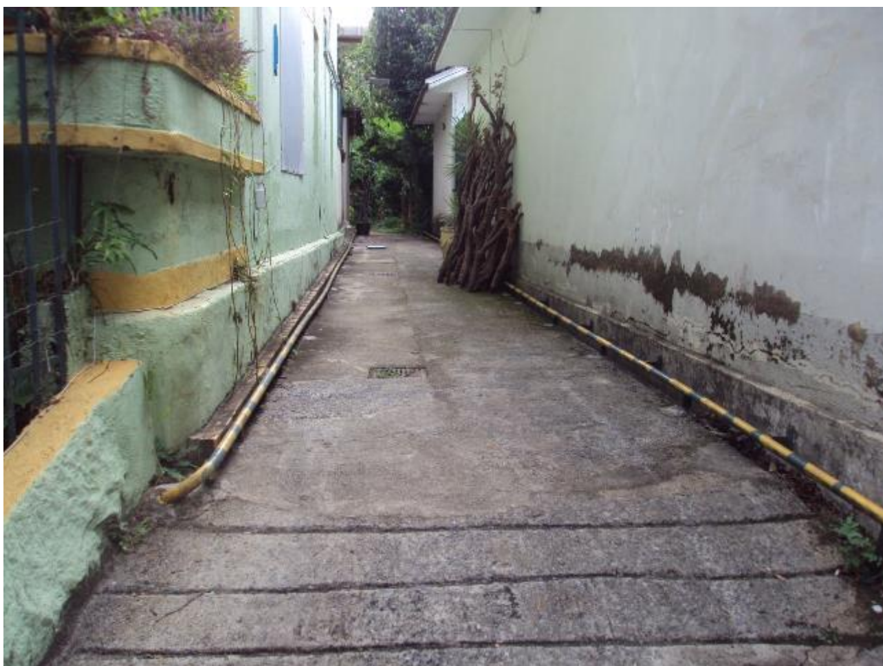
Foto do afastamento entre as duas casas tombadas que dá acesso aos fundos do lote. Pretende-se deslocar a parede da edificação à direita, de forma a ampliar o acesso. Fonte: vistoria DPCA em 2011.
