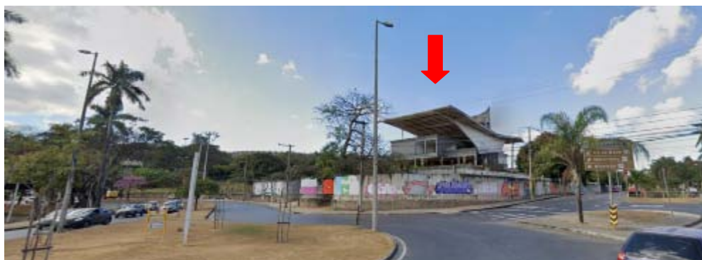
Vista da edificação existente no lote. Fonte: GoogleStreetView
