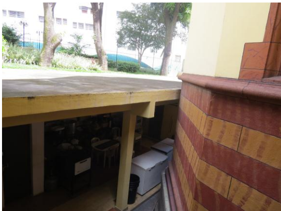
Readequação do volume da cantina de forma a retirar a parte da laje da cantina que encosta no volume da igreja, em sua parte posterior (já apontado).
