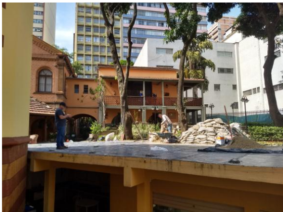
Vista da laje da cantina, em obra do jardim. Fonte: DPCA. Data: Dez/2018
