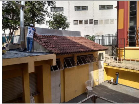
Vista dos banheiros e parte da cantina, ao lado do salão paroquial. Fonte: DPCA. Data: Dez/2018
