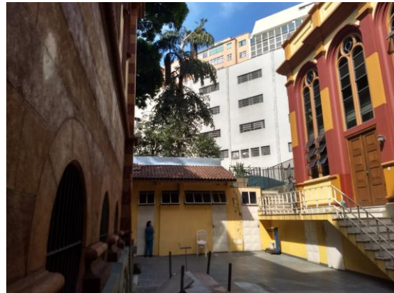
Vista da área entre a igreja e o salão paroquial. Ao fundo, os banheiros públicos. Fonte: DPCA. Data: Dez/2018
