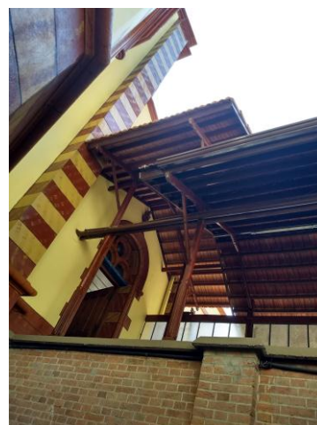
Vista parcial do passadiço. Fonte: DPCA. Data: Dez/2018
