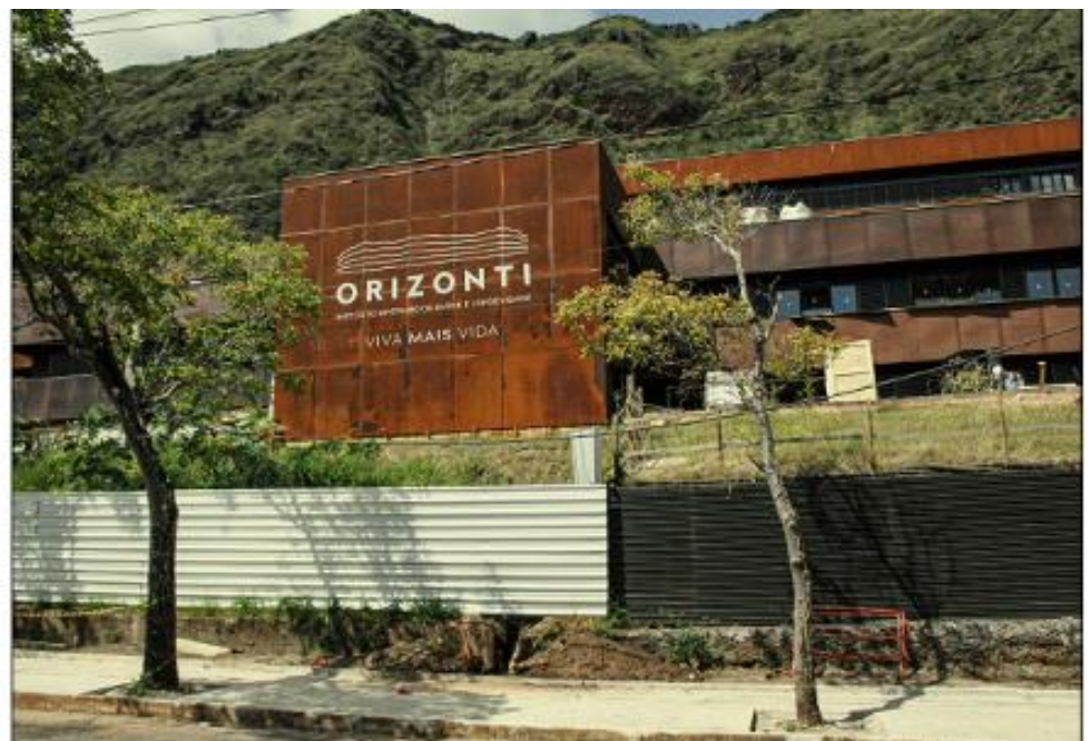
Marca aplicada na fachada – pórtico voltado para a Avenida José do Patrocínio Pontes.
