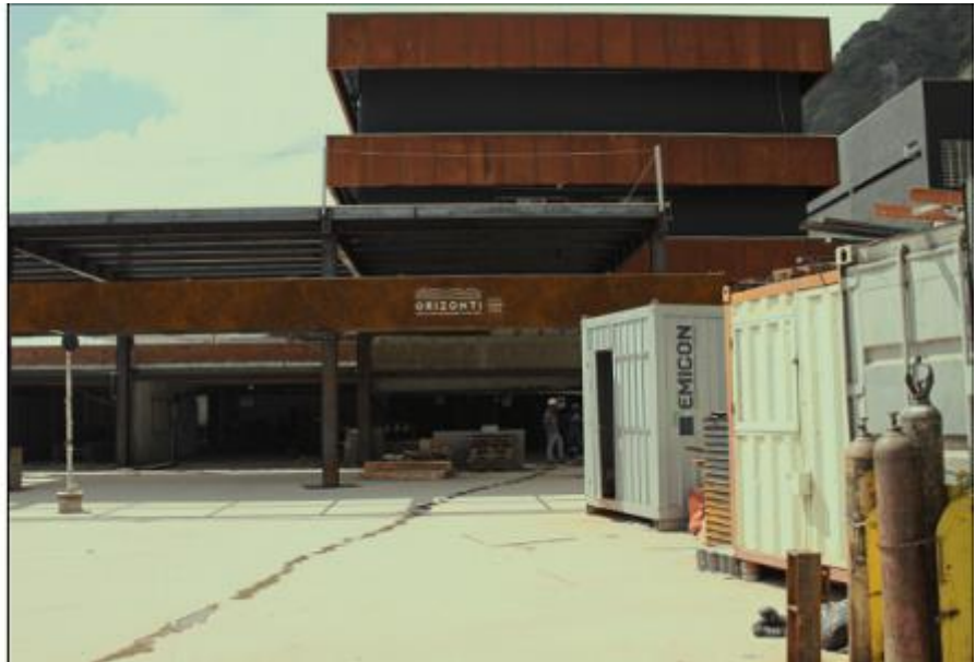
Marca aplicada na fachada – testeira junto à fachada lateral direita. Fonte: material encaminhado pelo interessado.
