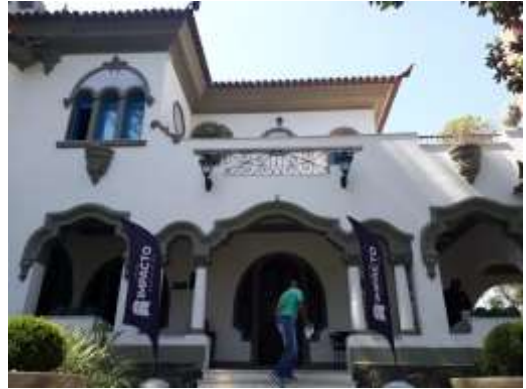
Fachada principal. Fonte: Vistoria externa DPCA 09/09/2020.
