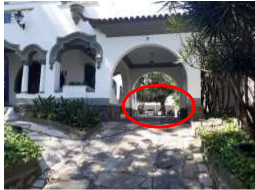
Fachada principal. Detalhe cobertura aos fundos. Fonte: Vistoria externa DPCA 09/09/2020.
