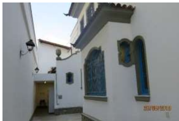
Afastamento lateral esquerdo. Fonte: Vistoria DPCA 26/08/19.
