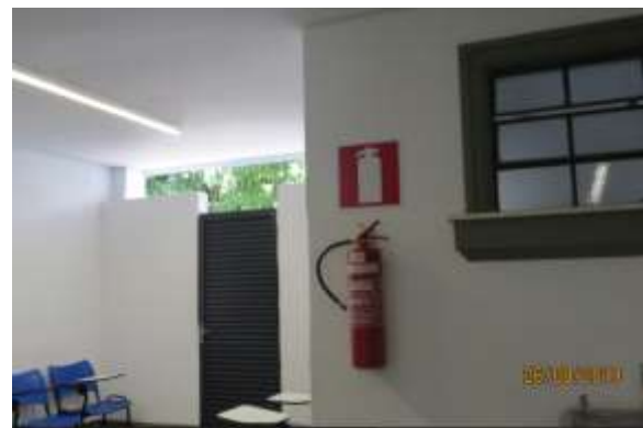
Porção posterior esquerda do nível térreo. Fonte: Vistoria DPCA 26/08/19.
