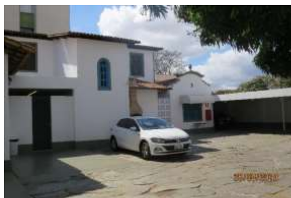
Afastamento e fachada posteriores. Fonte: Vistoria DPCA 26/08/19.
