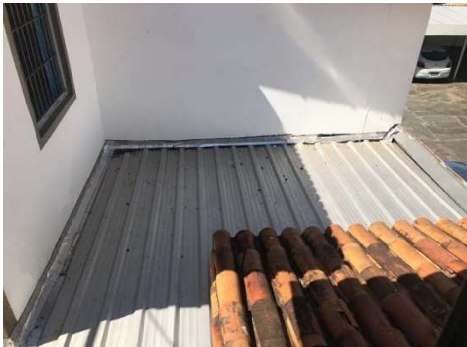
Lado esquerdo e posterior do volume principal, originalmente área aberta, agora com fechamento com gesso e cobertura metálica para proteção contra intempéries. Fonte: material fornecido pelo proponente.
