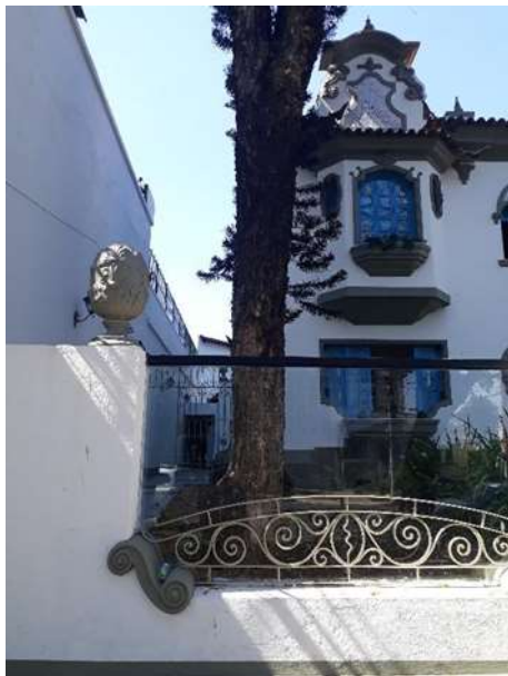
Fachada principal. Fonte: Vistoria externa DPCA 09/09/2020.
