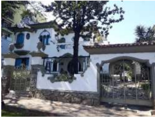
Fachada principal. Fonte: Vistoria externa DPCA 09/09/2020.
