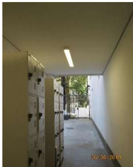
Porção posterior esquerda do nível térreo. Fonte: Vistoria DPCA 26/08/19.
