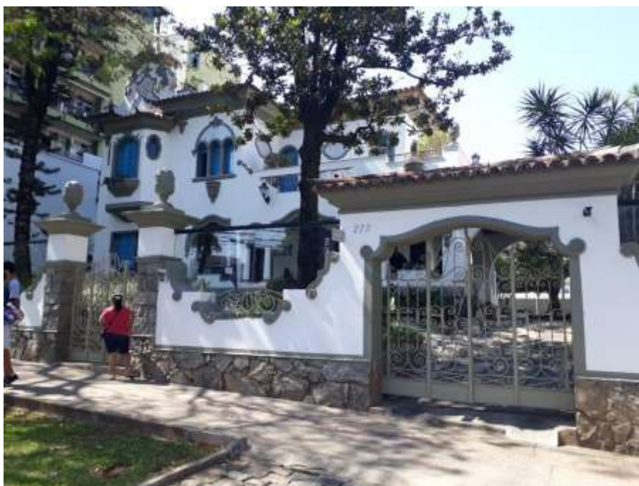
Vista da fachada principal do bem a partir do passeio da Av. Assis Chateaubriand. Detalhe vãos em arcos plenos e em canga de boi e sobrevergas ornamentadas. Fonte: Vistoria externa DPCA 09/09/2020.
