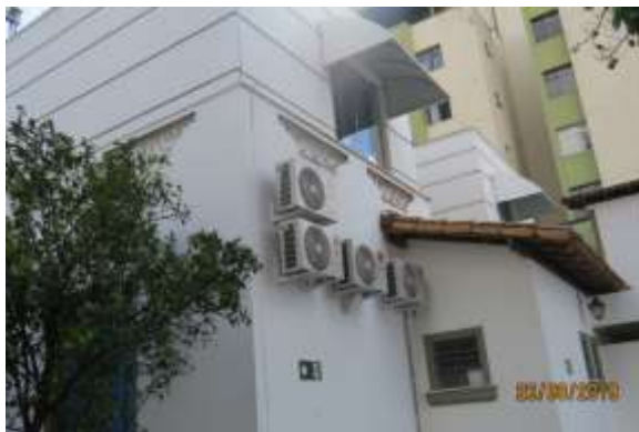
Área construída sobre edícula. Fonte: Vistoria DPCA 26/08/19.
