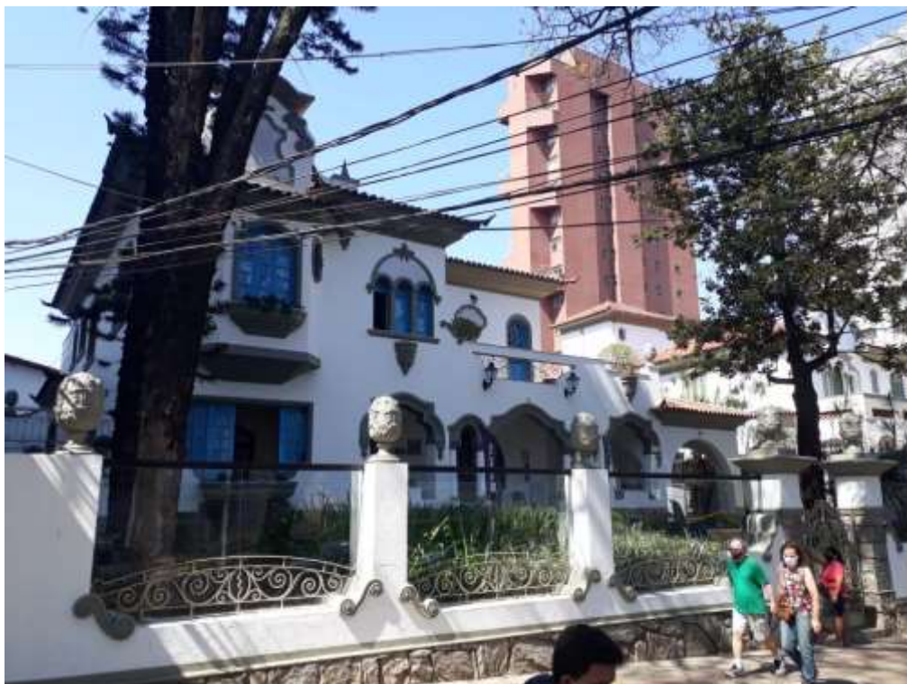
Vista da fachada principal do bem a partir do passeio da Av. Assis Chateaubriand. Detalhe fechamento frontal em alvenaria, gradis ornamentados e vidro e embasamento revestido em pedras irregulares. Fonte: Vistoria externa DPCA 09/09/2020.
