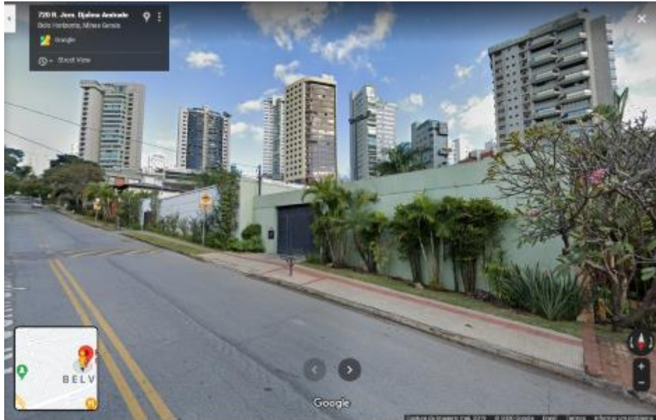
Vista geral da Rua Jornalista Djalma Andrade, mostrando o imóvel que se pretende regularizar, com destaque para a continuidade com o muro da casa vizinha. Fonte: GoogleMaps, acesso em 07/12/2020.
