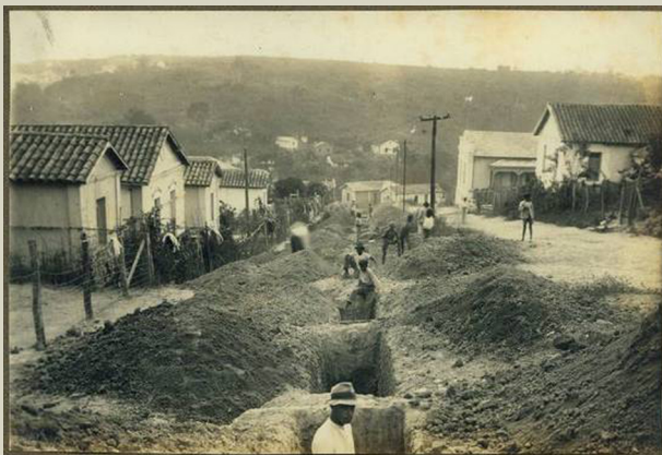
Obras de canalização de esgoto Autor não identificado 1922 - 1926 Coleção Belo Horizonte / Acervo MHAB
