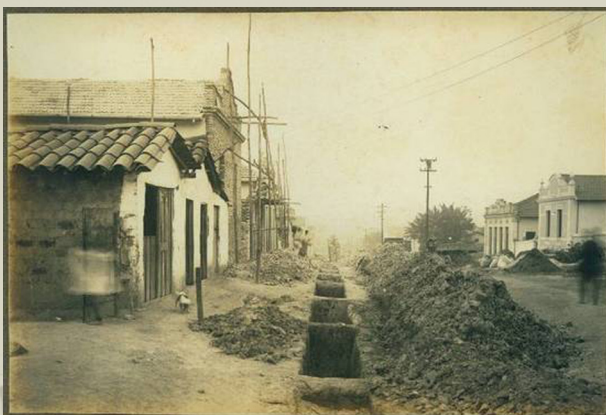
Obras de canalização de esgoto - Rua Mato Grosso Autor não identificado 1922 - 1927 Coleção Belo Horizonte / Acervo MHAB
