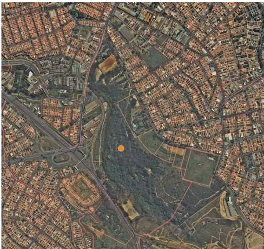
Imagem 01: Lote CTM 101386600930, Quadra CTM 1013866, Zona fiscal 463, Bairro Estrela do Oriente. (fonte: bhmap.pbh.gov.br)
