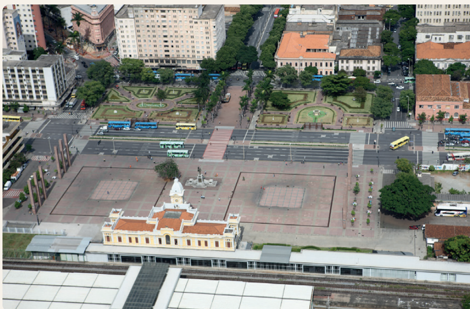
Avenida dos Andradas após as obras da Linha Verde, 2008. Fundo ASCOM/APCBH
