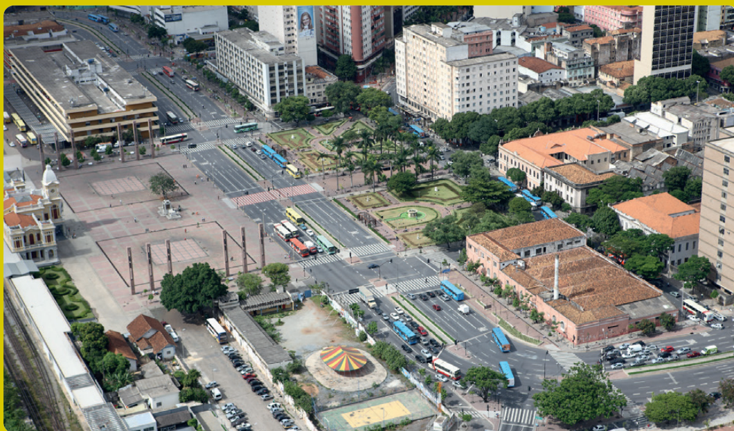
Avenida dos Andradas após as obras da Linha Verde, 2008. Fundo ASCOM/APCBH
