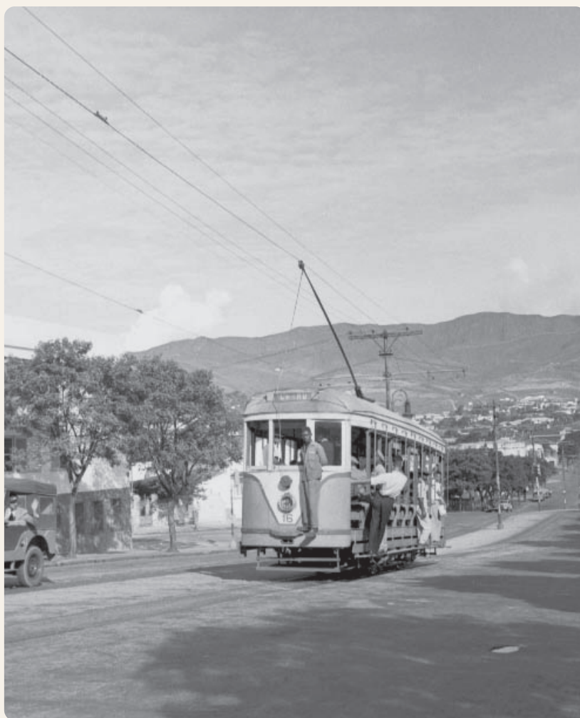
Bonde elétrico na Avenida Cristóvão Colombo. Fundo ASCOM/APCBH
