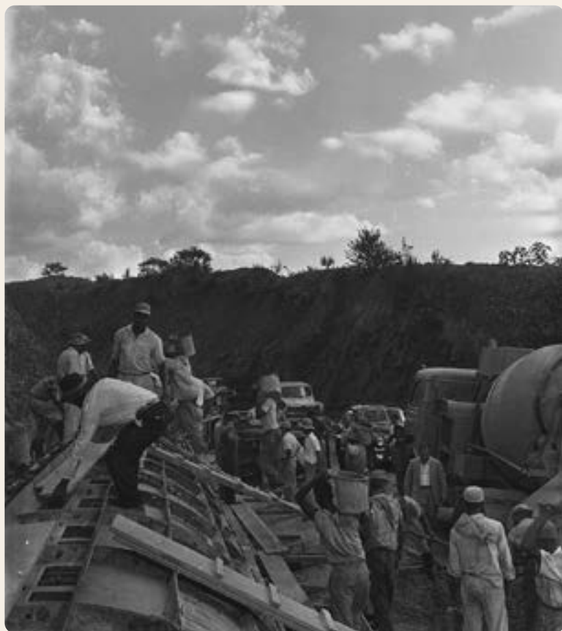
Obras da Adutora do Rio das Velhas, 1961. Fundo ASCOM/APCBH
