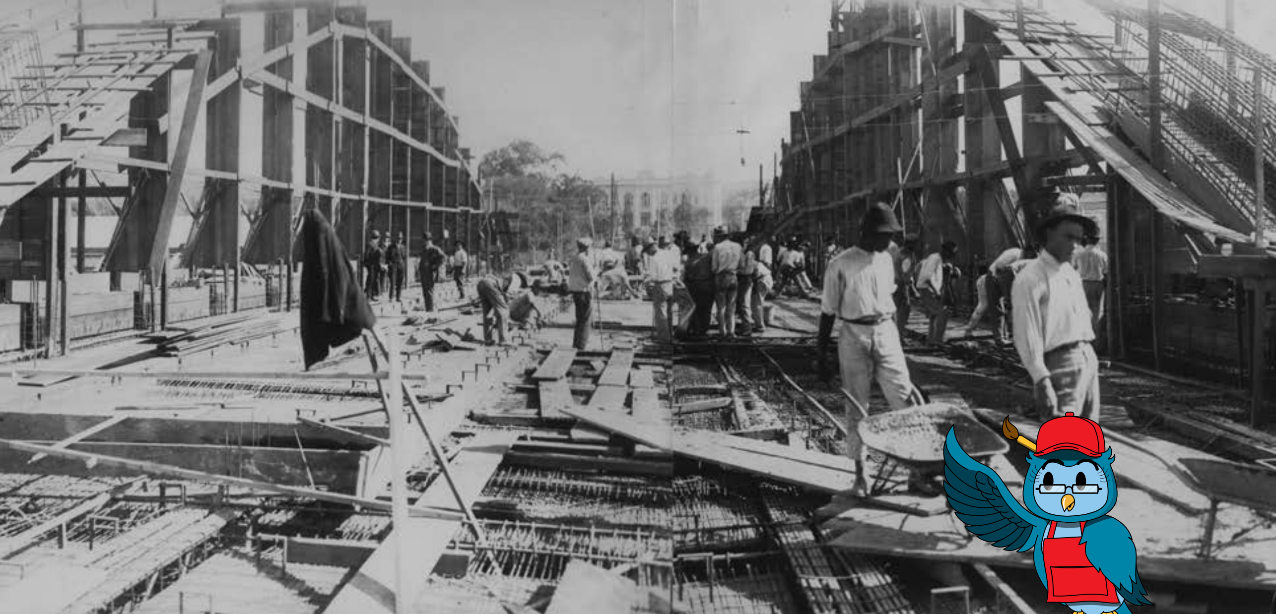
Construção do Viaduto Santa Tereza, 1928. Doação Maria Alice Garcia de Mello/APCBH
