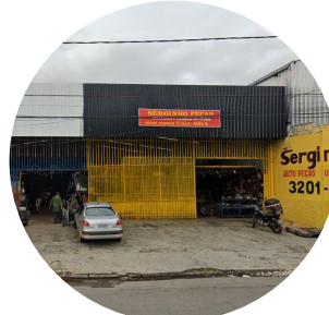
Alta presença de Galpões (1.183)
