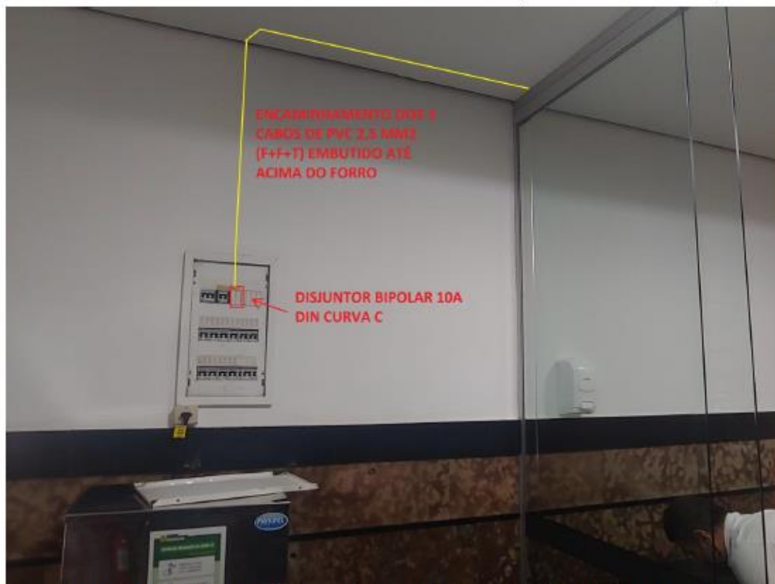
Figura 1: Encaminhamento dos 3 cabos não halogenados de seção 2,5mm 2 (F+F+T) embutidos na parede até acima do forro.
