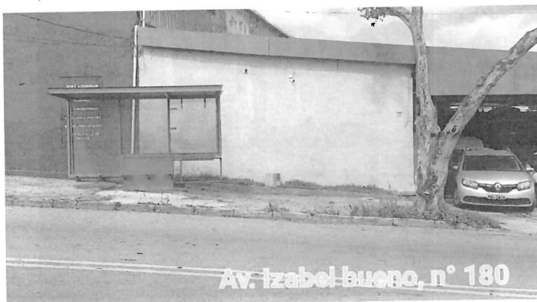
Sem sinalização horizontal de piso tátil
