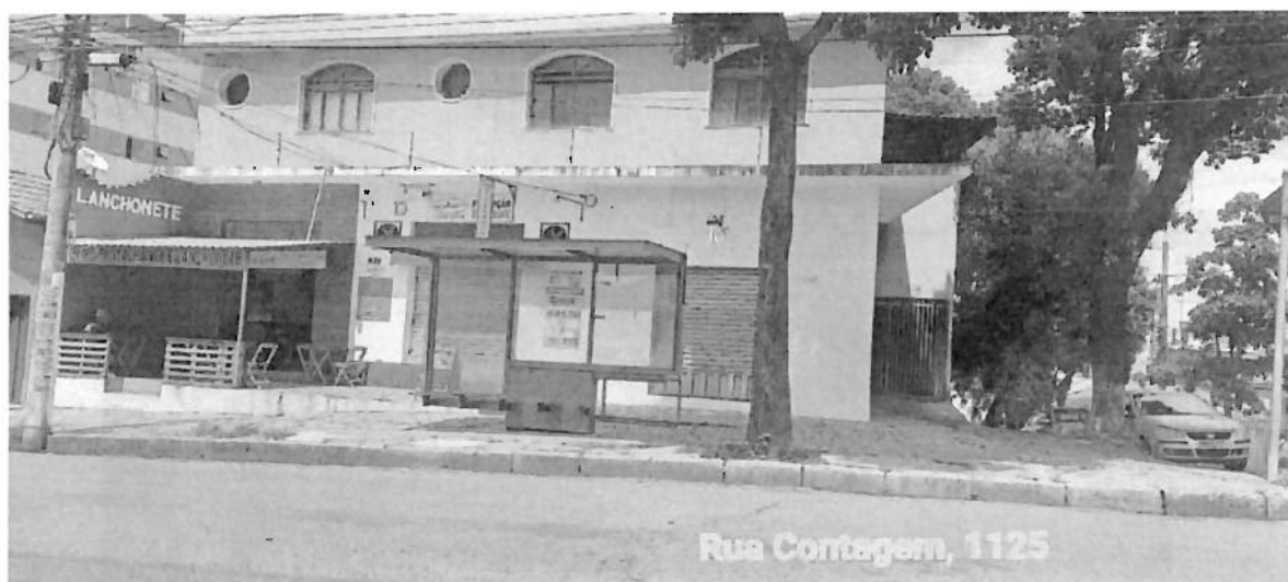
Sem sinalização horizontal de piso tátil
