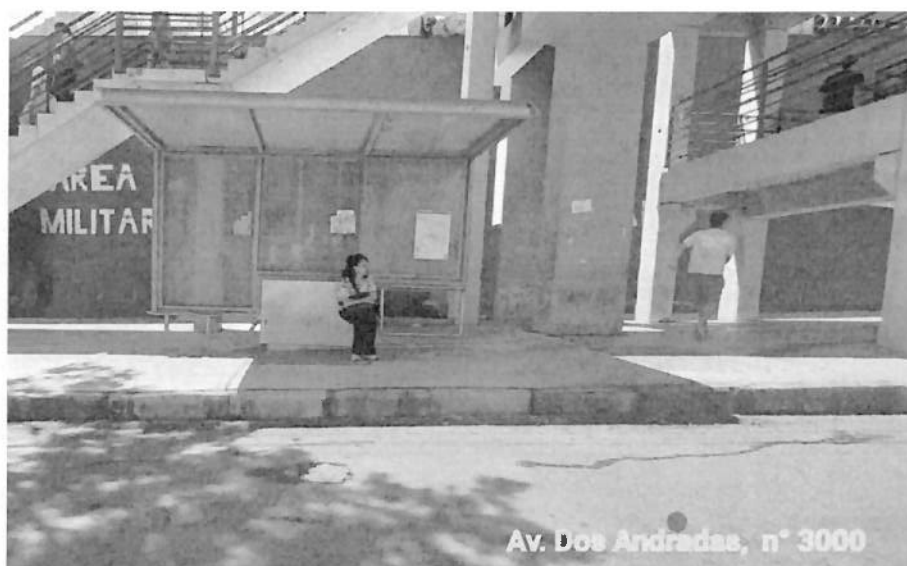
Sem sinalização horizontal de piso tátil
