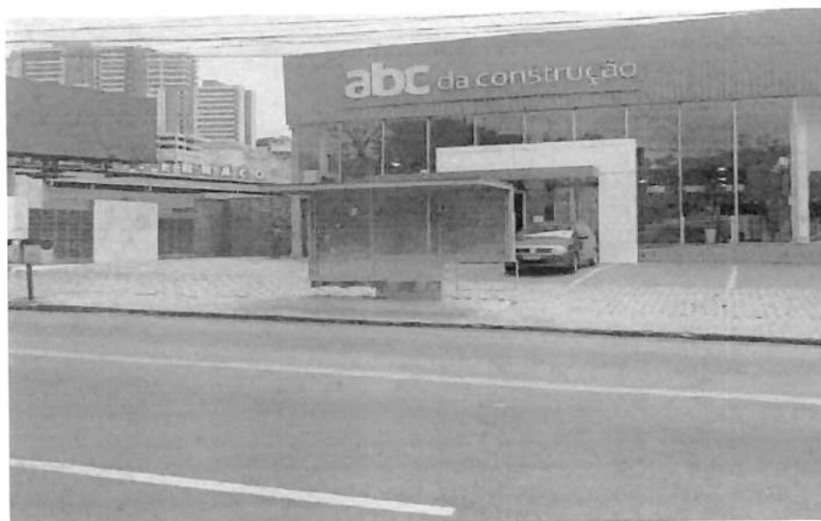
Cor do abrigo fora do padrão
