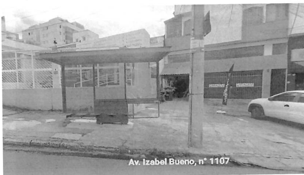
Sem sinalização horizontal de piso tátil
