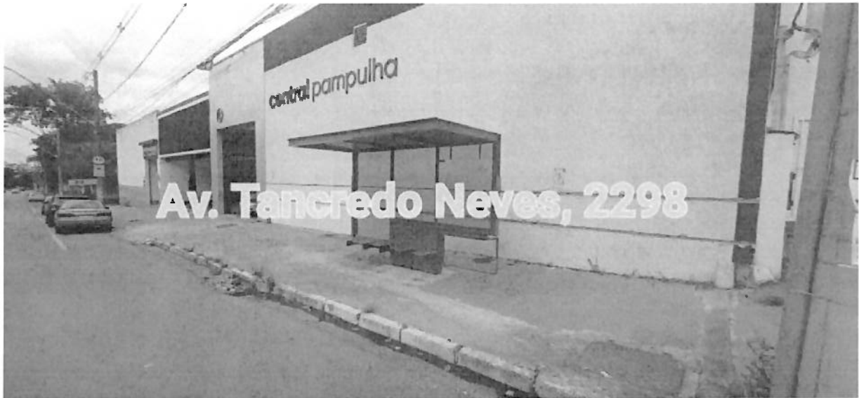
Sem sinalização horizontal de piso tátil
