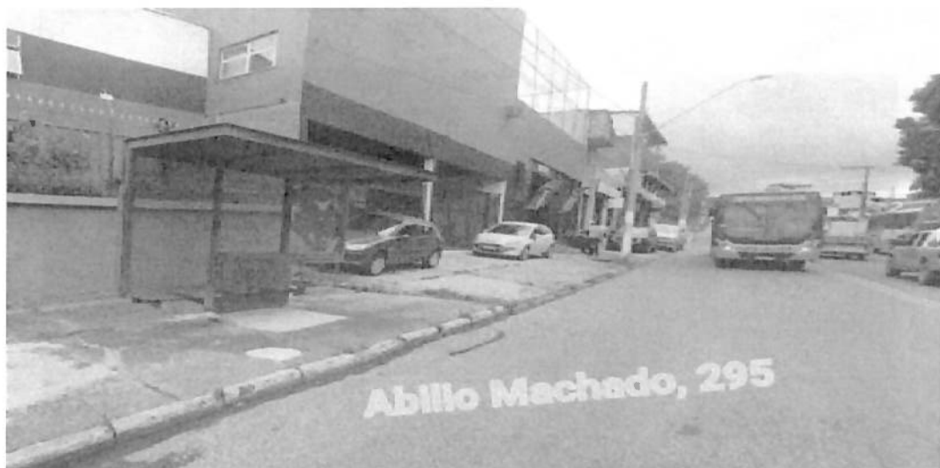
Sem sinalização horizontal de piso tátil
