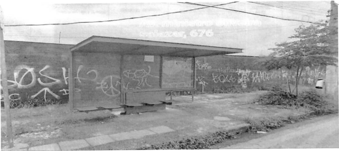
Correção da sinalização horizontal de piso tátil
