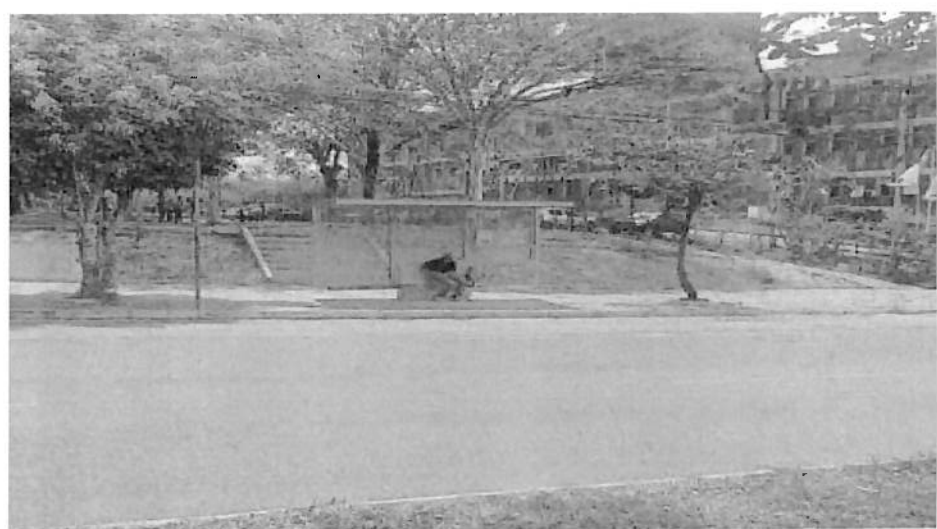
Cor do abrigo fora do padrão
