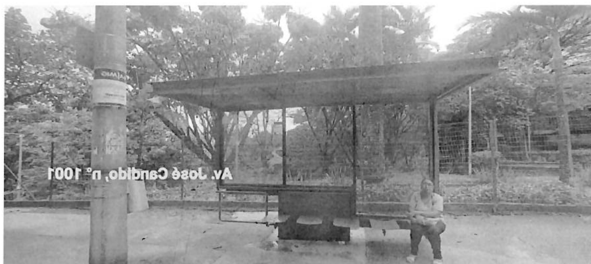
Sem sinalização horizontal de piso tátil
